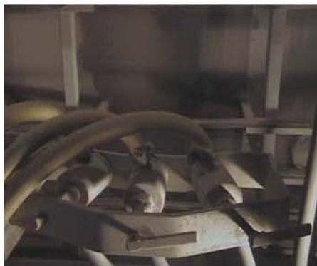
Figura 2.4 Montaje de boquillas
