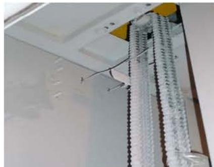
Figura 5.10 Varillas de sensores y gavilán
