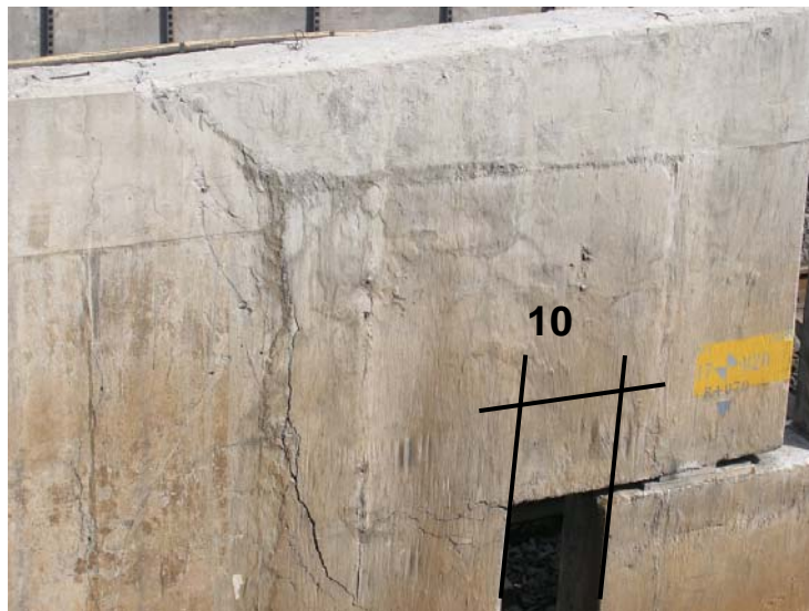
Figura 3.7 Junta de expansión (cadenamiento 17+020)
