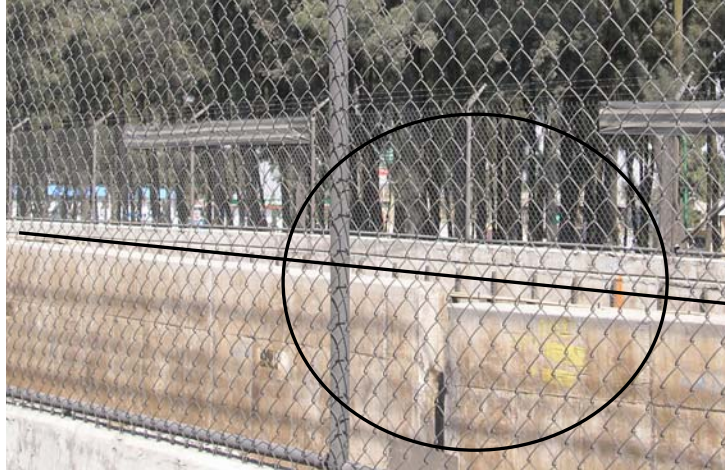
Figura 3.6 Junta de construcción (cadenamiento 17+490)
