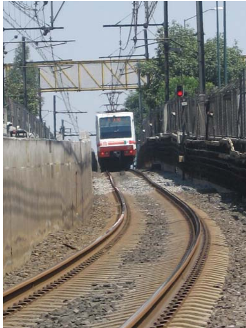
Figura 5.14 La deformación que el suelo le impone al cajón del metro, se refleja en el sistema de vías cad 17+500
