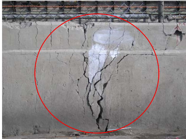
Figura 3.17 Falla por momento positivo, compresión en los muros (cadenamiento 21+280)
