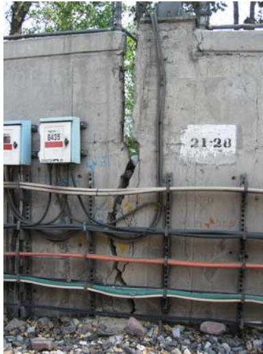
Figura 5.11 Falla por ruptura del acero, momento negativo, cad 21+337
