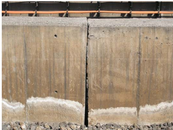
Figura 3.5 Junta de construcción (cadenamiento 19+035)
