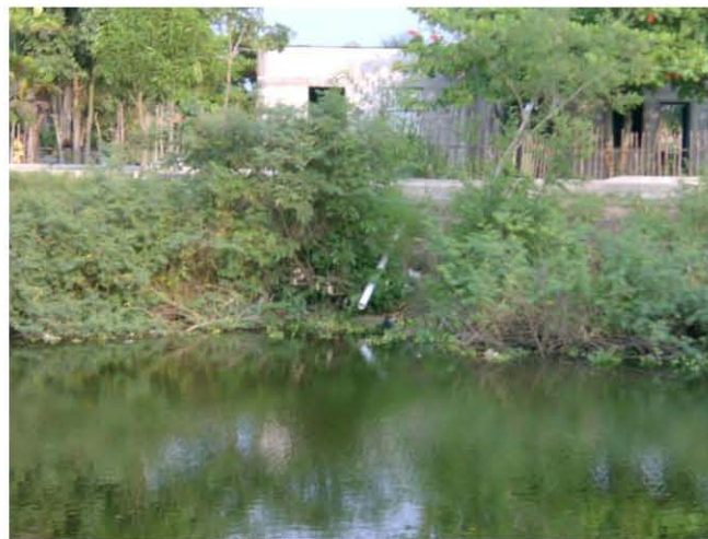
Descarga de aguas negras al cuerpo de agua
