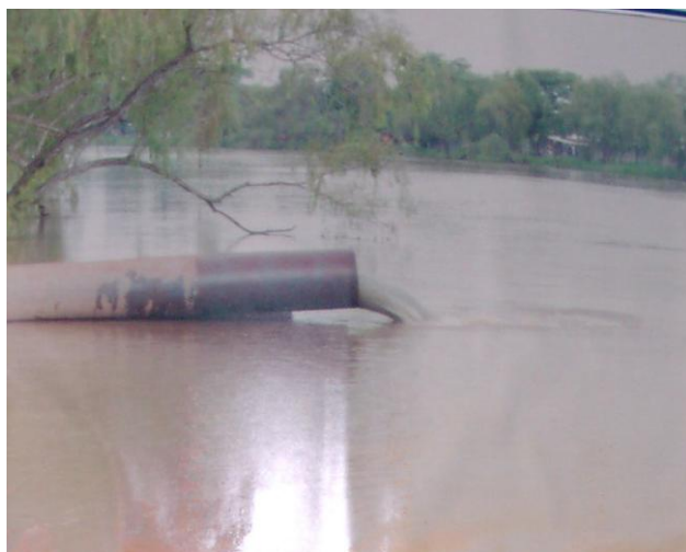
Descarga de aguas residuales directamente al río
