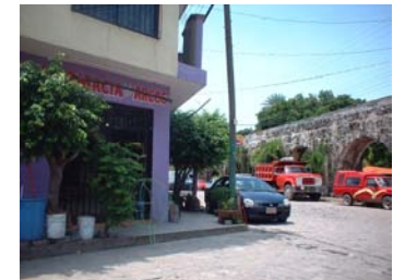
Foto: Autoconstrucción en locales comerciales
