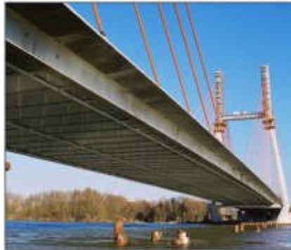
Fig. 1.26 Protección catódica sobre la superficie del concreto de los puentes.
