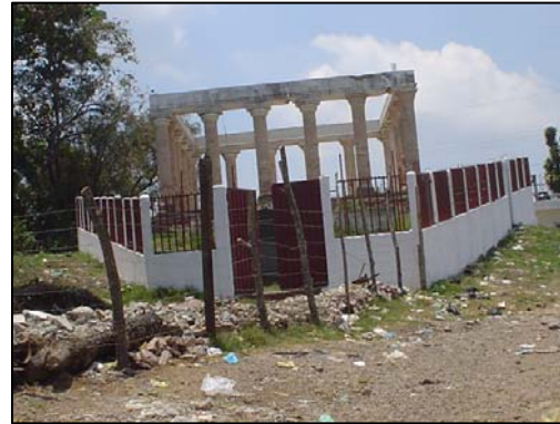
Foto No. 5.71 El Templo a Minerva durante años anteriores a su actual intervención, sufrió de abandono, llegando a formar parte de un problema principal del municipio, la creación de basureros clandestinos. Fuente: Autor
