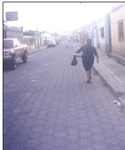
Foto No. 5.78 Sobre el eje urbano la mayoría de calles son adoquinadas, esta calle mide 7 metros y la banqueta mide 1 metro.
