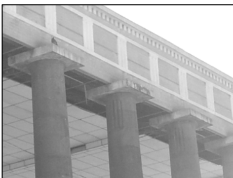
Foto No. 6.20 Parte lateral del templo en donde se aprecia la modulación de los triglifos y metopas en el entablamento sobre las columnas.
