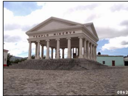
Foto No. 5.32 El Templo tiene cuatro tímpanos, y seis columnas por lado, todo el templo presenta acabado blanqueado.
