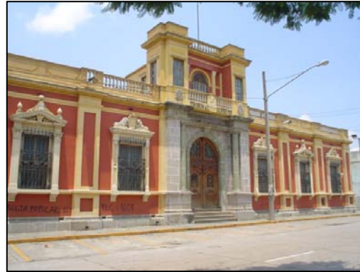
Foto No. 5.4 Originalmente residencia (Casa Yurrita) hoy Oficina del Tribunal Supremo Electoral, ubicada sobre la Sexta Avenida Zona 2. Fuente: Autor
