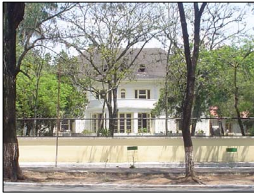
Foto No. 5.9 Residencia ubicada sobre lo que era la Avenida Minerva, hoy Avenida Simeón Cañas Zona 2. Fuente: Autor
