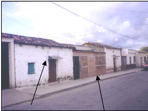
Vivienda construida de adobe y cubierta de teja.
