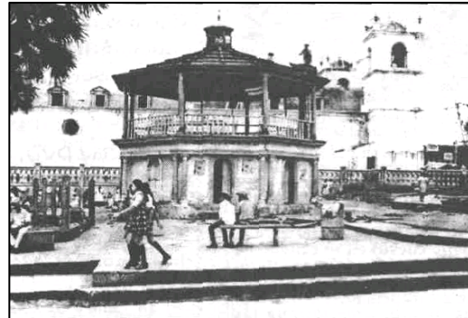
Foto No. 5.63 Desaparecido Kiosco ubicado en el Parque Barrios, hoy Telgua
