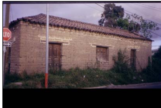
Foto No. 5.76 Arquitectura del género habitacional, con sistema constructivo vernáculo, adobe expuesto, cubierta de teja de barro, ver las proporciones en donde los masizos predominan sobre los vanos. Esto sobre el entorno inmediato del Templo
