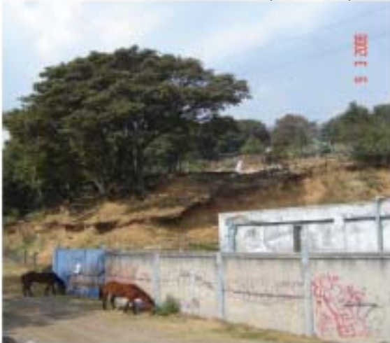
FIGURA 4.13 TANQUE DE ALMACENAMIENTO(EL ZAUCO)
