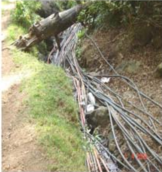
FIGURA 4.11 RÍOS DE MANGUERAS NEGRAS
