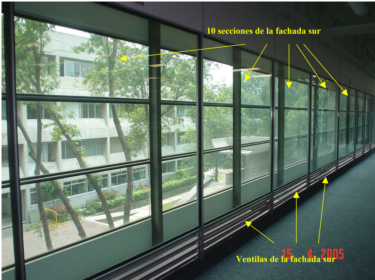
Fig. 4.7. Fotografía de la pared sur del edificio, mostrando las ventilas que permiten la introducción de flujos de aire externo al edificio.
