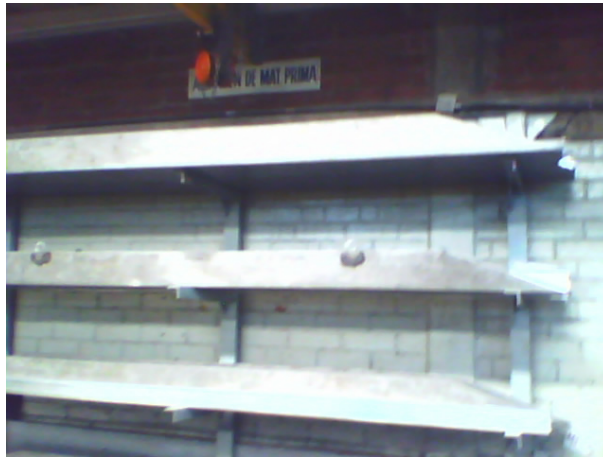
Figura 4.5 Anaqueles para almacenar lámina de acero
