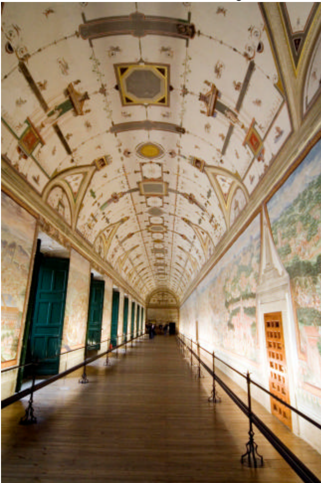
Foto 47. Bóveda a cañón corrido de la Sala de Batallas de El Monasterio de San Lorenzo de El Escorial. En esta bóveda se pintaron grutescos en el contexto de las batallas.
