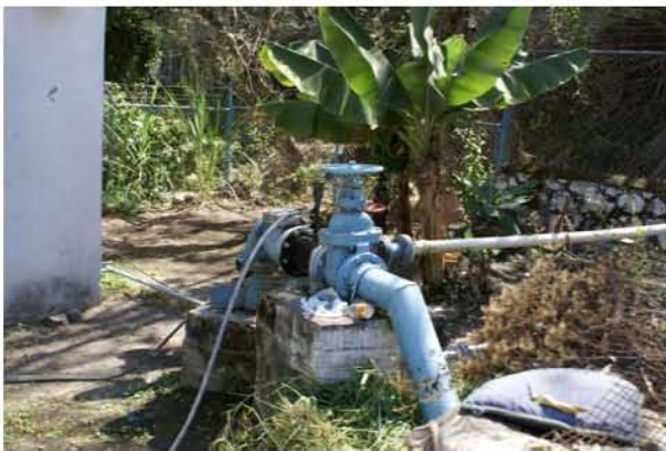
Fotografía 3. Pozo La Presa
