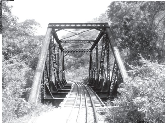
Estructuras típicas de Acero ubicadas sobre el Rió Pantaleón, departamento de Suchitepequez, localizadas sobre el Distrito del Pacifico.
