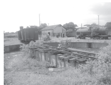
Detalle de la situación en que se encuentra en la actualidad la casa redonda de Mazatenango, 2004.
