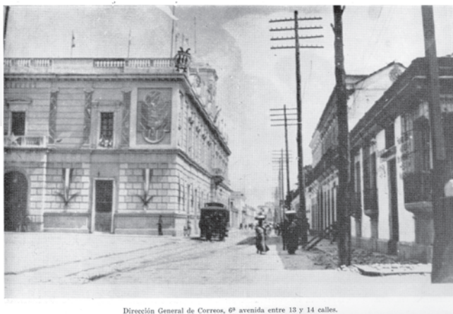
Dirección General de Correos, 6ª avenida entre 13 y 14 calles.
