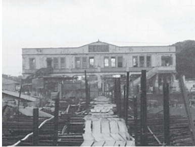
Fachada posterior del edificio administrativo de la Estación de Puerto de San José Escuintla, década de 1930, administración de Jorge Ubico.
