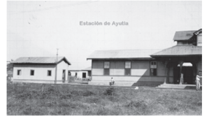
Edificio de Bodega y andén de carga Estación Ayutla/Tecún Umán, San Marcos. 1900.
