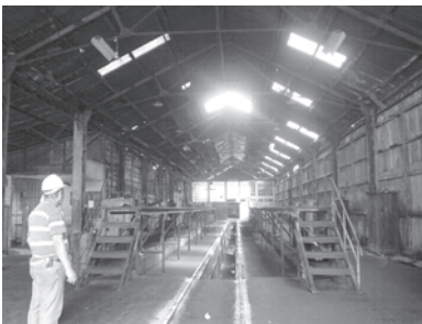
Taller de Reparación de locomotoras ubicado en la Estación Central-Guatemala.
