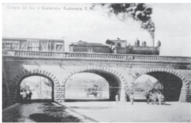
Puente sobre la 6ta. Avenida de la zona 4 de Guatemala, década de 1950.
