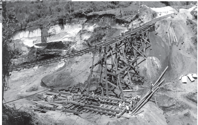
Proceso de reconstrucción del Puente Santa Ana en el año de 1926, el cual había colapsado debido al desbordamiento del río, dañando las bases de su estructura.
