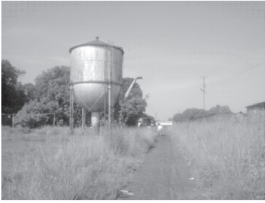
Situación actual de la zona de abastecimiento de agua, el área de la ferrovía fue levantada y colocado asfalto en el sector.
