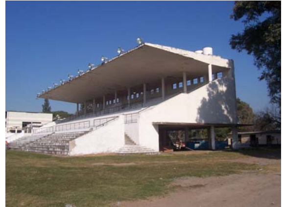
6 Vista Actual Foto Hugo Ahumada Ostengo
