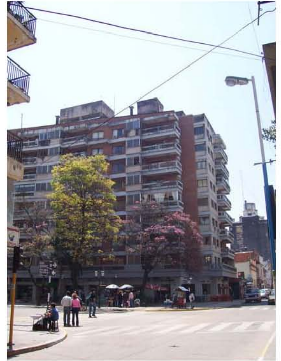
7 Vista Edificio 24 de Setiembre y Rivadavia
