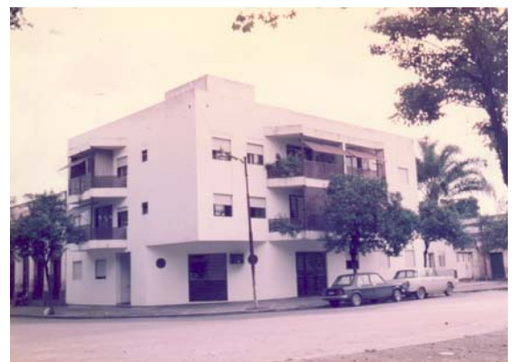
10 Edificio en Lavalle 1175 Exterior
