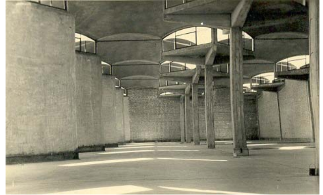
14. Vista Interior edificio Servicios anexos, circa 1954. Fuente: Archivos personales del arquitecto Horacio Lobo van Gelderen y de Ignacio Lobo Bugeau..
