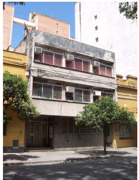
3 1956 Edificio para oficinas de, Lamadrid 468 Interesante proyecto racionalista con patio central. Estado actual oficina pública municipal en estado deplorable.
