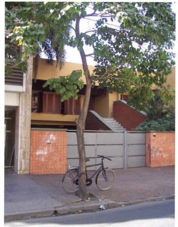
4 Vista Vivienda Wesler Chacabuco
