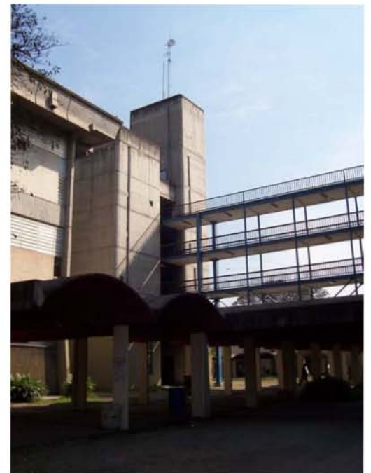
6. Torre de Servicios y pasarelas entre blocks.
