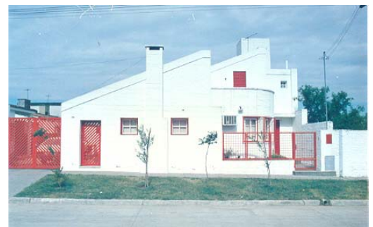
8 Vivienda Galíndez Junín y Estrada Tucumán 1982
