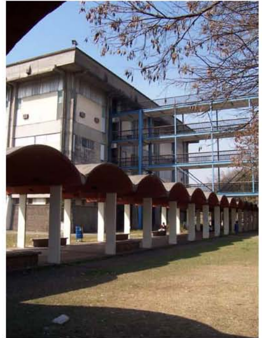
7. Blocks y bóvedas de circulaciones generales.
