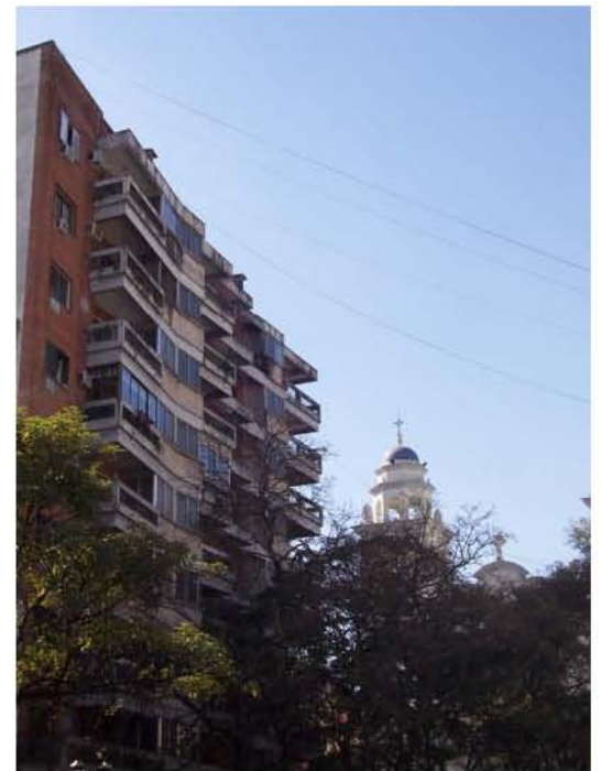
8 Vista y Detalle de la fachada edificio 24 de setiembre y Rivadavia.
