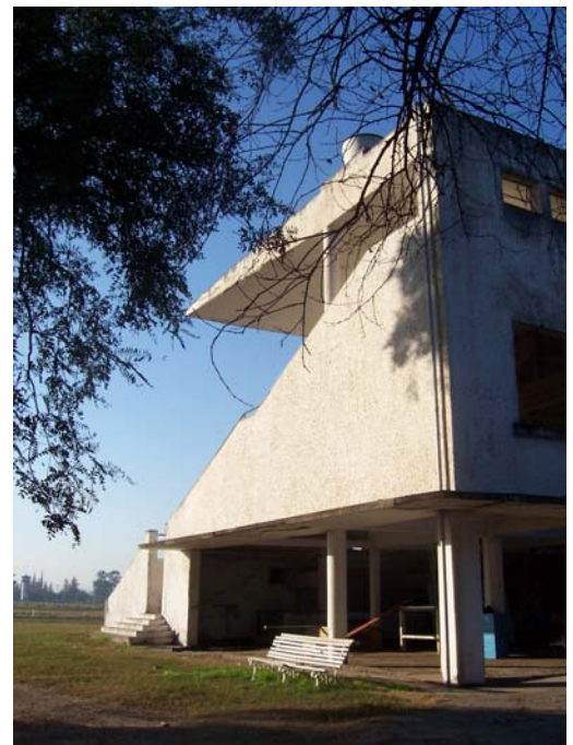
5 Vista actual Foto Hugo Ahumada Ostengo
