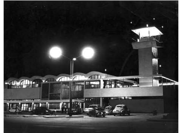
5 1961 Edificio Aeropuerto Matienzo.
