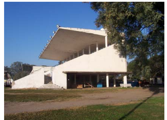
3 Vista actual de Edificio del Hipódromo de Ricardo Marré.
