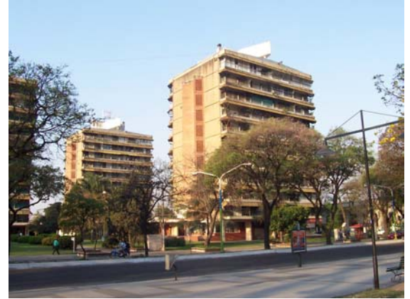
10. Conjunto de Edificios para Previsión Social. 25 de mayo y Av. Sarmiento. 1956 Director de proyecto Rodolfo Mitrovich. Adjuntos Jorge de Lassaletta, Juan Carlos Viola
