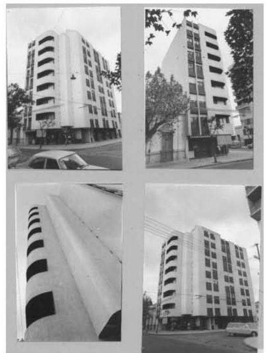
18 Edificio Alco Paje Padilla y Salta Tucumán
