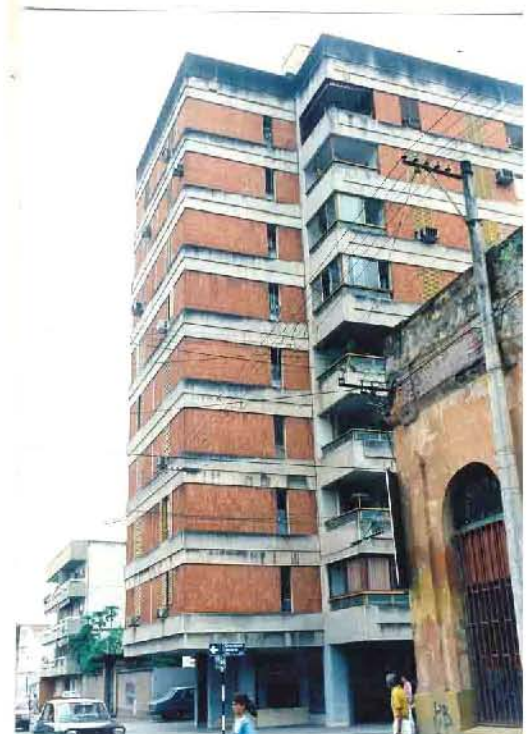
6 Edificio en altura, Entre Ríos y Crisóstomo Álvarez Tucumán 1973 Foto R. Serrano
