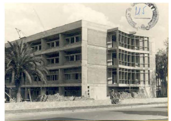
5 Centro de Salud nuevo pabellón Asociado a Eduardo Sacriste
