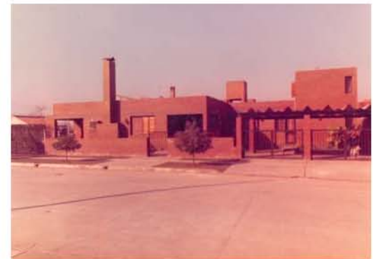
10 Vivienda Romero 1980 Vista exterior
