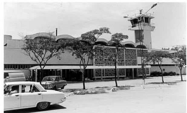
6 1961 Edificio Aeropuerto Matienzo. Hoy funciona una escuela fueron cerrados sus terrazas laterales alterándose la morfología general del edificio.
