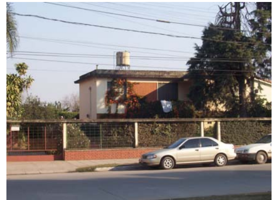
3 Vivienda Sr. Saade. Yerba Buena 1957
