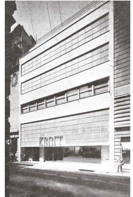
6 Edificio Kraft. Sacriste y Di Paola. Revista de Arquitectura Febrero de 1940.
