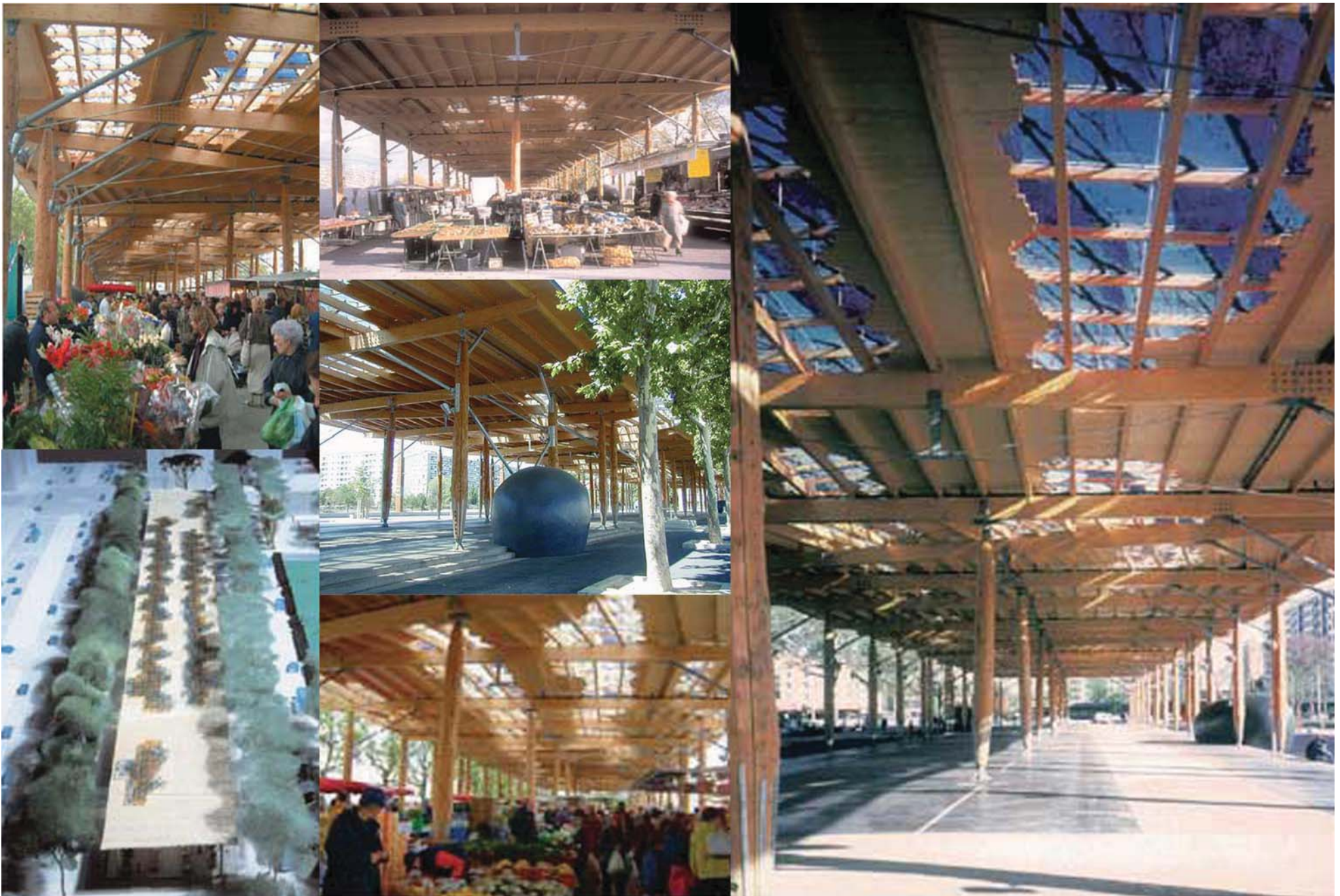
Mercado, " Plaza 8 de Mayo". Jourda Architectes. Lyon.Francia. 2007.- -Marché, " Place 8 Mai". Jourda Architectes. Lyon. France. 2007.
