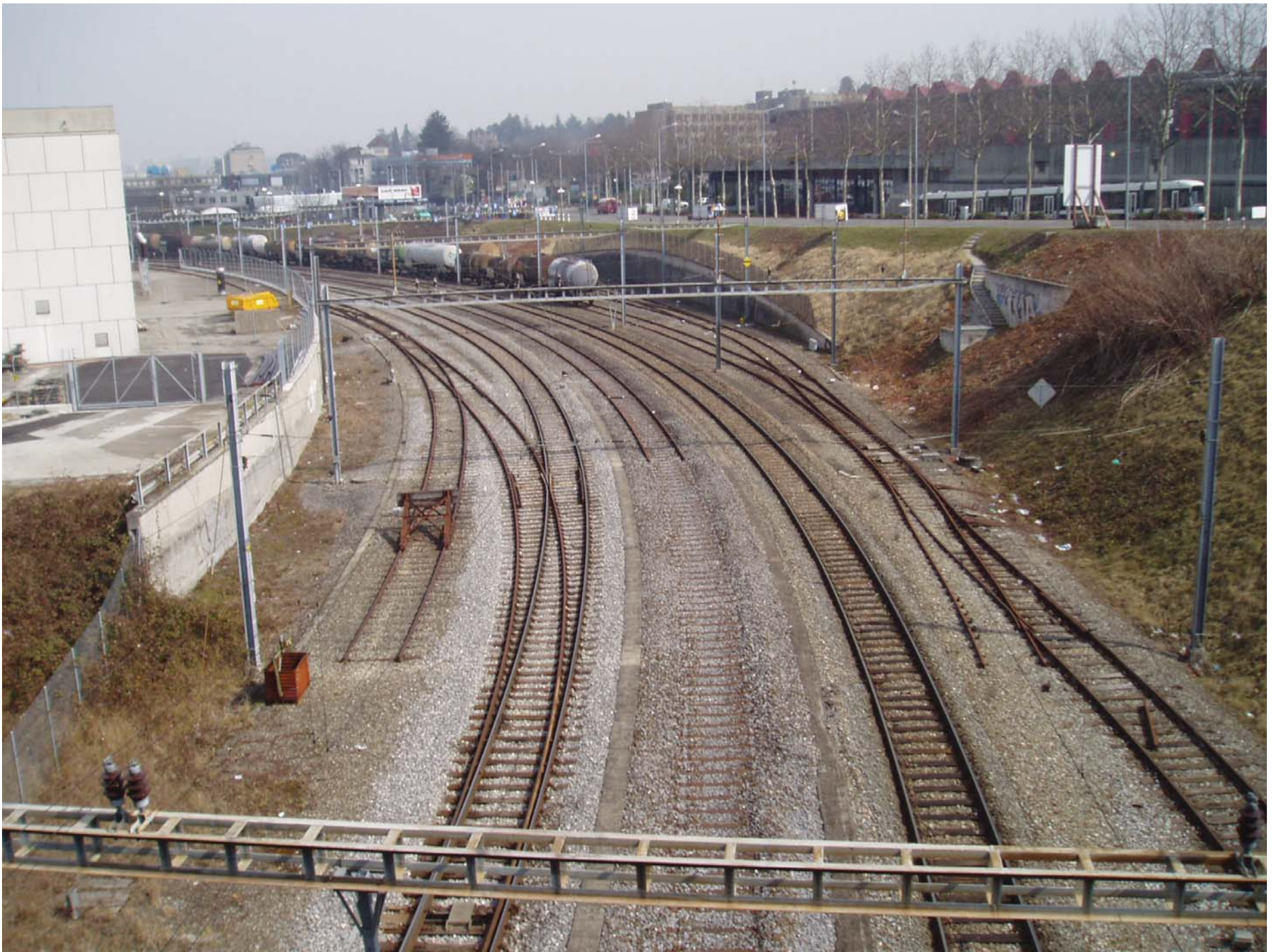
Zona ferroviaria de transporte industrial al sur de Ginebra. Suiza. 03-2006.- -Zone ferroviaire de transport industriel au sud de Genève. Suisse. 03-2006.
