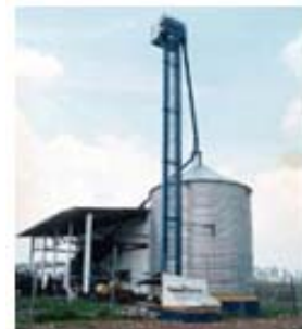
Figura 5. Planta de elaboración de alimento
