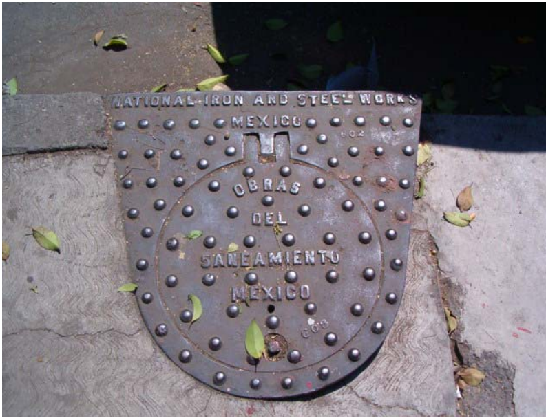
Imagen 50. Como se observa en la imagen la mayor parte de las coladeras son las originales que puso la compañía Nacional Iron and Steel Works , en la primer década del siglo XX. Foto A. Contreras, enero 2007.
