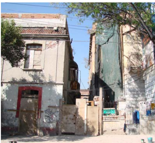
Figura 53. Espacio que se genera entre ambos inmuebles. Foto A. Contreras, abril 2007.
