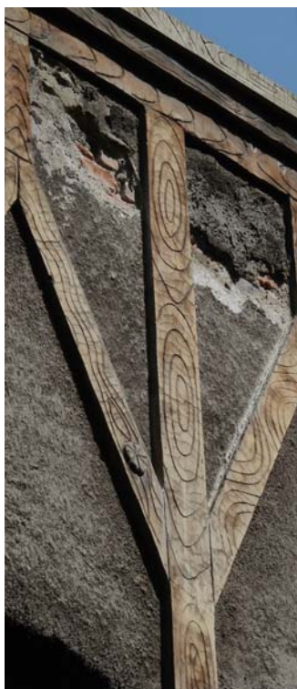
Imagen 71. Detalle de apoyo vertical. Foto A. Contreras, abril 2006.
