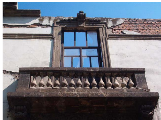
Imagen 100. Calle de Puebla en donde se esta demoliendo poco a poco la casa al interior.
