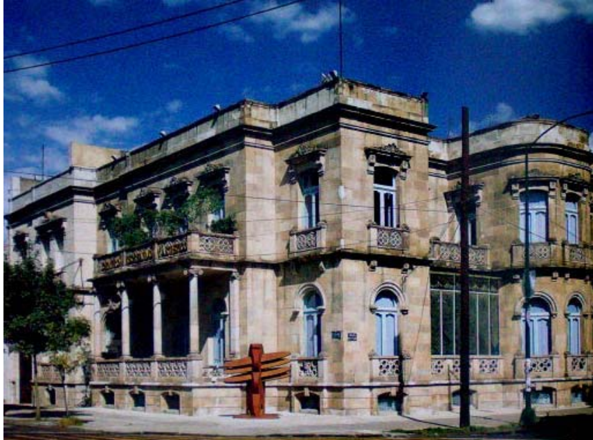
Imagen 76. Vivienda Unifamiliar ubicada en la esquina de las calles de Colima y Orizaba. Foto A. Contreras, mayo 2002.
