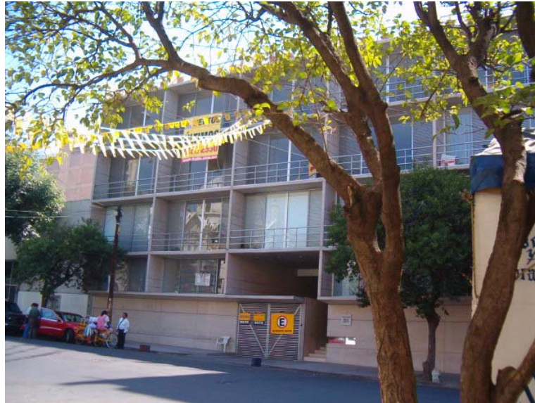
Imagen 49. Edificio de departamentos en la calle de Orizaba # 36. Foto A. Contreras, abril 2007.
