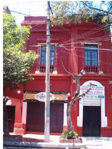
Imagen 106. Jalapa # 37. Edificio que subdividido, en una parte se colocó una pequeña cafetería y la otra parte está destinada a una escuela.
