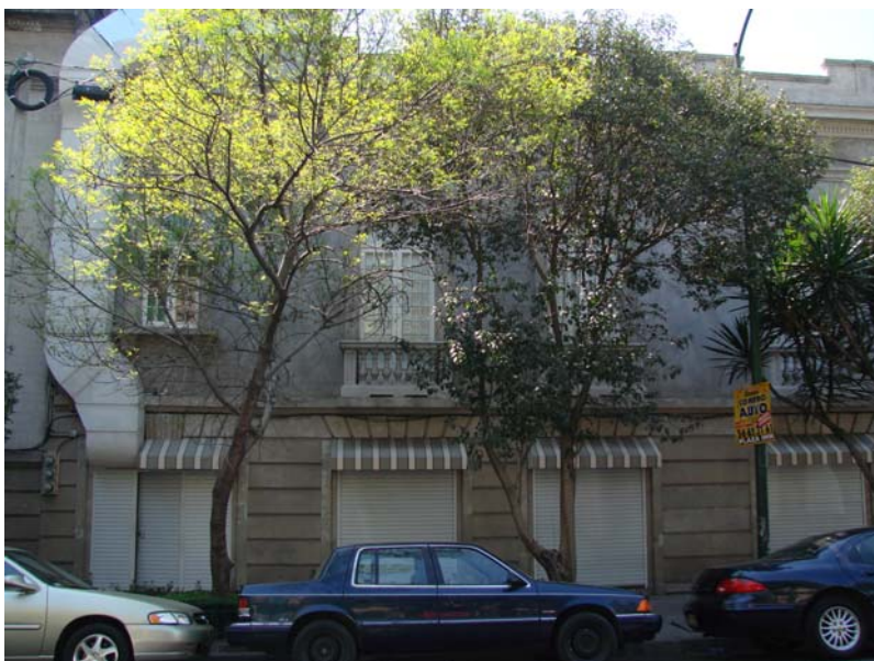
Imagen 101. Orizaba No. 28 esquina con Puebla, en donde se observa de lado izquierdo la tubería del extractor de aire del restaurante.
