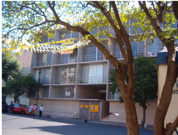
Imagen 99. Edificio nuevo de departamentos en la Calle de Orizaba No.36.
