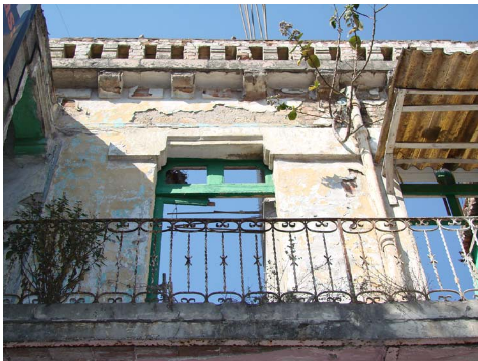
Imagen 19. Se observa como la superficie del edificio se esta disgregando en varias zonas. Tonalá # 47. Foto: A. Contreras, abril de 2007.
