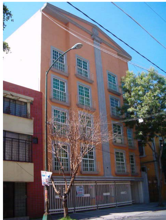
Imagen 51. Nuevo edificio de departamentos en la calle de Tabasco que rompe tipológicamente con el entrono, modificando el perfil urbano por la altura, los colores texturas y texturas. Foto A. Contreras, abril 2006.
