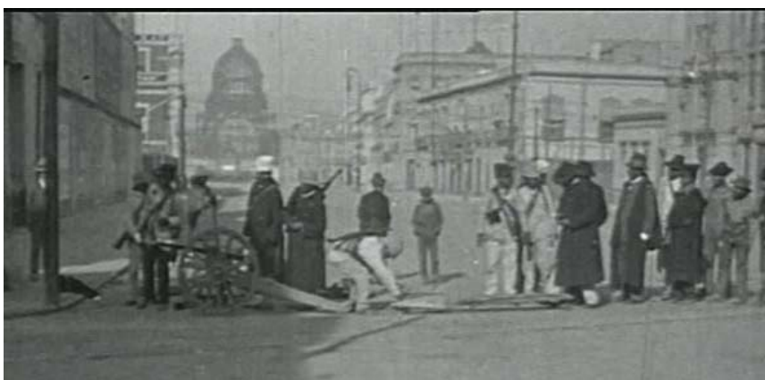
Imagen 8. Ciudad de México en 1913. Imagen donde se observa al fondo el Palacio legislativo en construcción y el primer plano los cañones.
