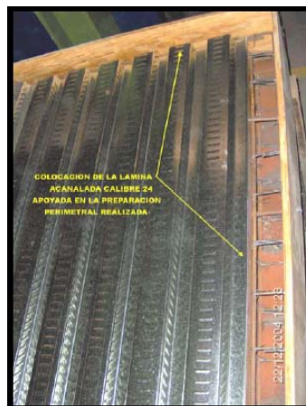
Figura 4.7 Detalle de colocación de lámina sobre armado perimetral
