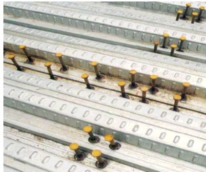
Figura 2.6 Sistema losacero con pernos de cortante
