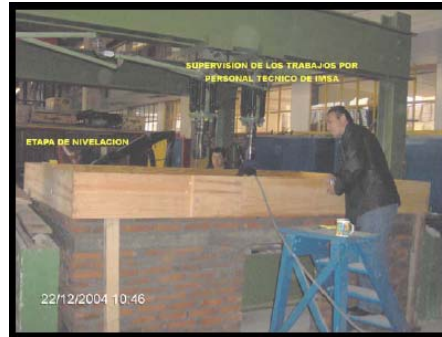
Figura 4.6 Técnicos de IMSA realizando la supervisión del proceso constructivo
