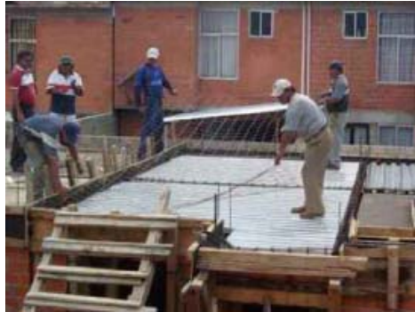
Figura 3.8 Colocación del refuerzo por temperatura
