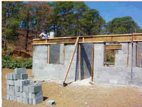
Figura 3.3 Preparación de los muros de apoyo
