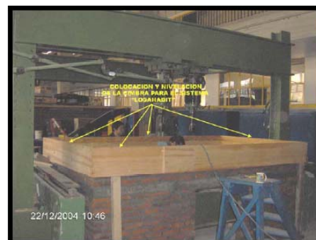
Figura 4.5 Colocación de la cimbra sobre la estructura de mampostería
