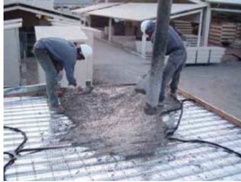
b. Vaciado del concreto
