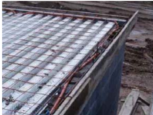
Figura 3.6 Fronteras en el perímetro empleando tablon
