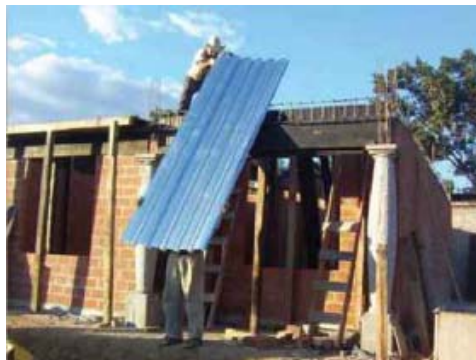
Figura 3.4 Izaje de la lámina losahabit
