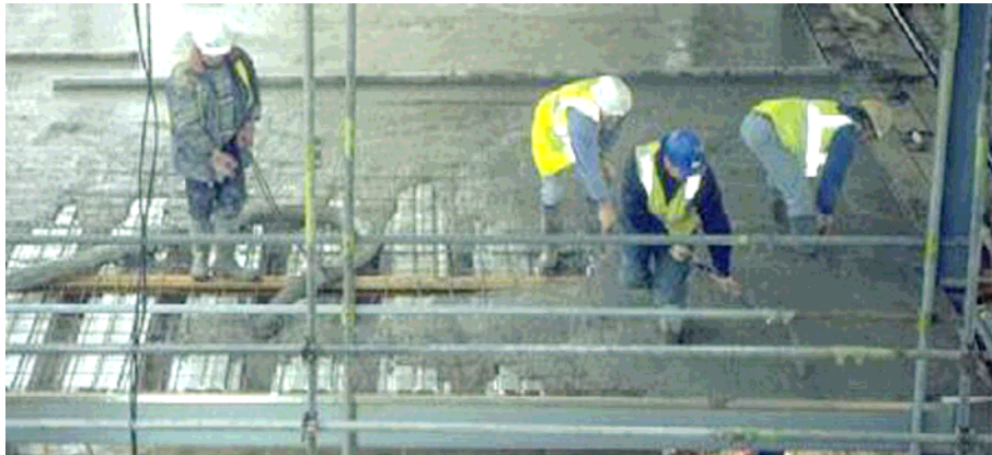
Figura 2.8. La lámina funciona como cimbra
