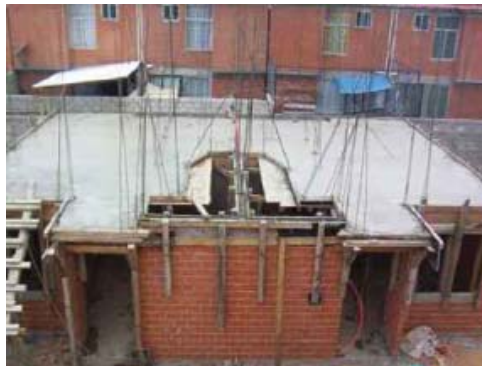
f. Losahabit terminada
