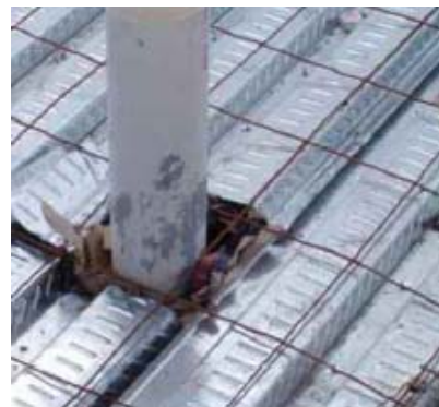
Figura 3.9b Colocación de las instalaciones sanitarias.
