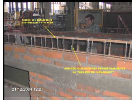
Figura 4.4 Colocación del refuerzo perimetral
