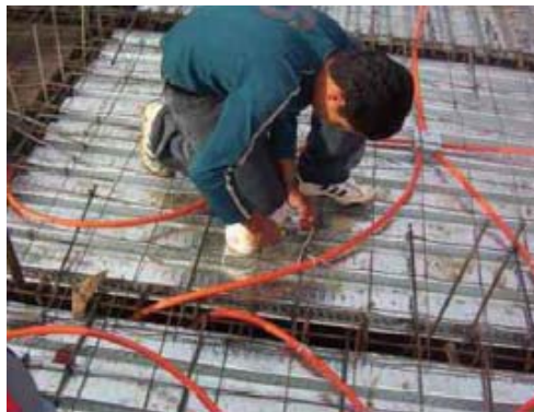
Figura 3.9a Colocación de las instalaciones eléctricas.
