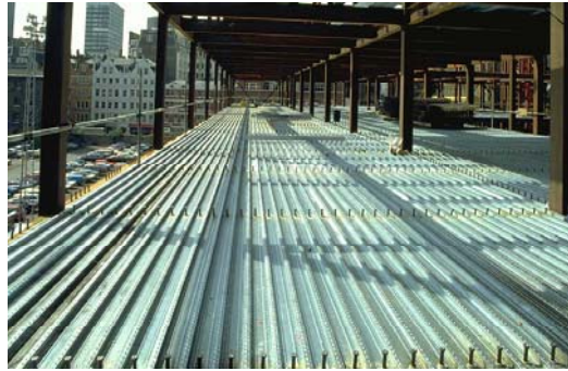
Figura 1.5 Entresijo metálico a base de marcos y vigas.
