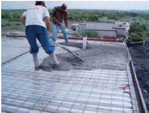
c. Distribución del concreto
