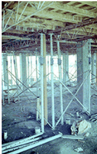
Figura 1.4 Cimbra para entepisos de hormigón armado
