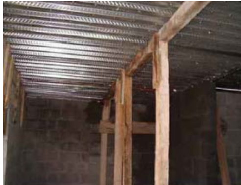
Figura 3.5 Apuntalamiento de la losahabit
