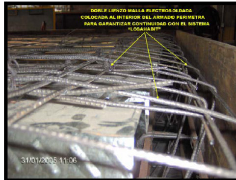
Figura 4.10 Doble del lienzo de malla electro soldada en la cadena perimetral y traslape con el lienzo principal para dar continuidad en el perímetro del sistema.
