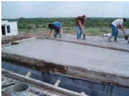
e. Enrase de la losa
