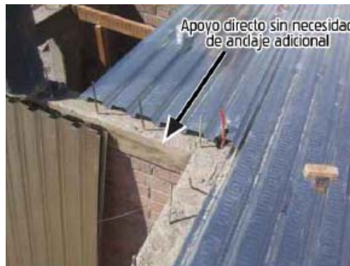
Figura 3.7 Instalación de losahabit directamente sobre muros
