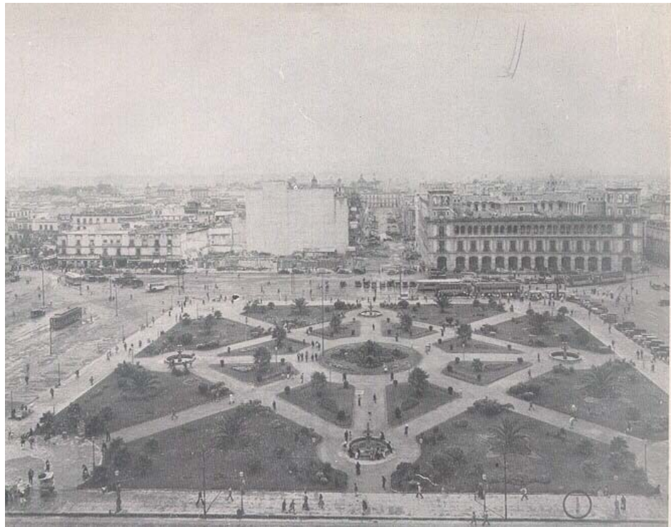
En la apertura de la avenida 20 de Noviembre en 1935 se aprecia parte de la demolición de los edificios en el terreno en que se construyó el edificio gemelo del Departamento del Distrito Federal.
