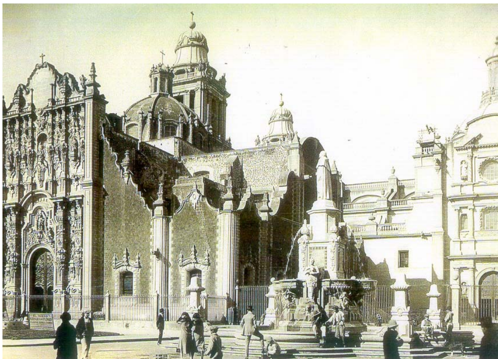
Construcción de la Fuente de Bartolomé de las Casas. Memoria del Ayuntamiento de la Ciudad de México 1925.
