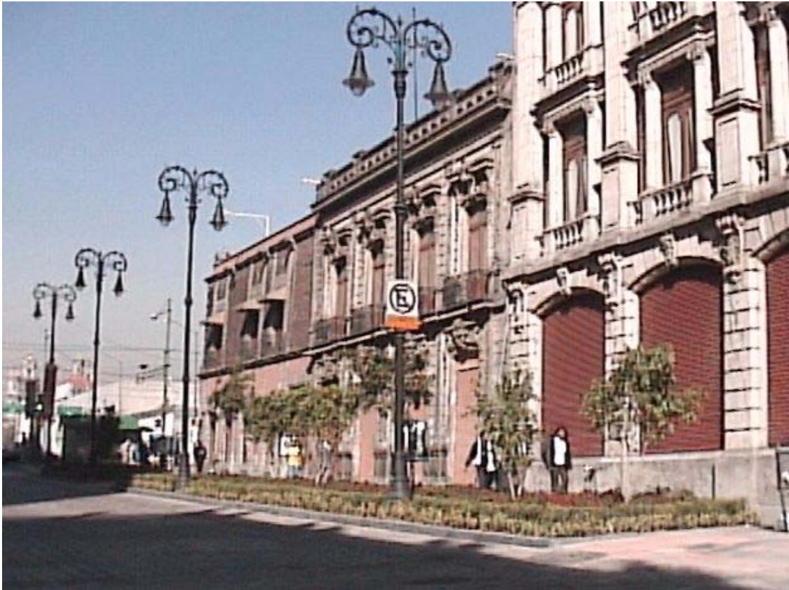
Primera calle de Tacuba después de su rehabilitación.
