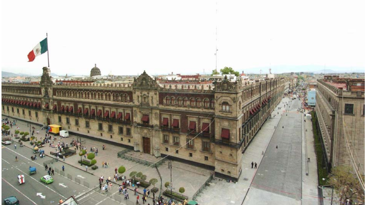
Aspecto de la 1ª calle de Corregidora después de las obras de rehabilitación.
