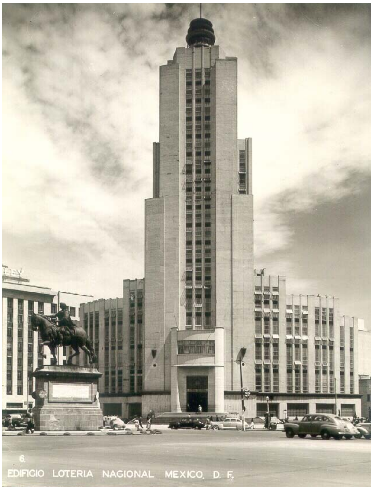
6. EDIFICIO LOTERIA NACIONAL MEXICO, D. F. En los años cuarenta se realizaba la construcción de edificios altos en la ciudad de México, con cimientos de “flotación” y estructura de concreto armado. Edificio de la Lotería Nacional, en la glorieta de “El Caballito”, cruce de Paseo de la Reforma con Avenida Juárez.
