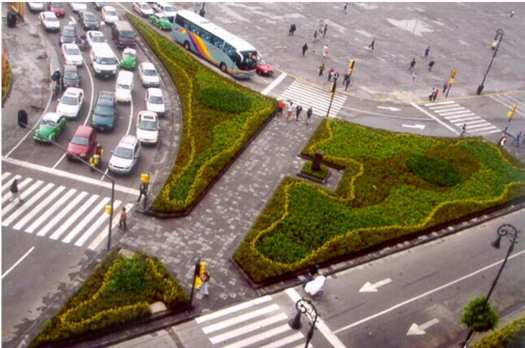
Dispositivo construido frente a la Plaza del Empedradillo para establecer el cruce de peatones y vehículos en la esquina de Monte de Piedad con 5 de Mayo y el paso a la Plaza de la Constitución.
