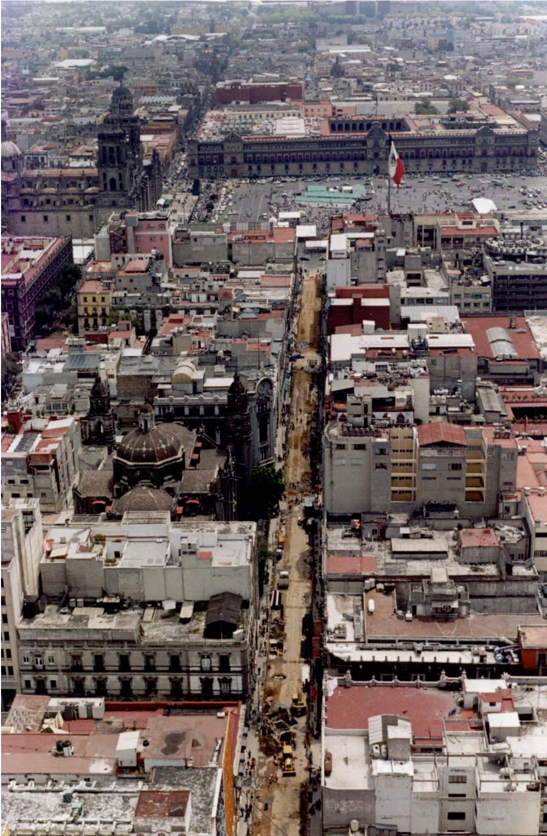
Obras en la calle de Madero
