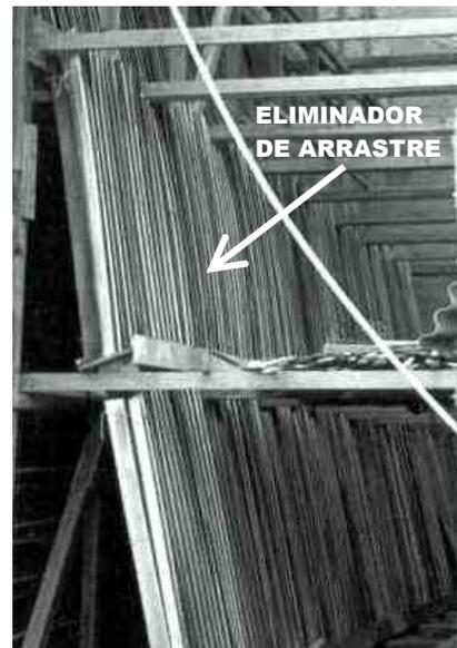
Figura 1.18 Eliminador de rocío, en una torre de flujo cruzado
