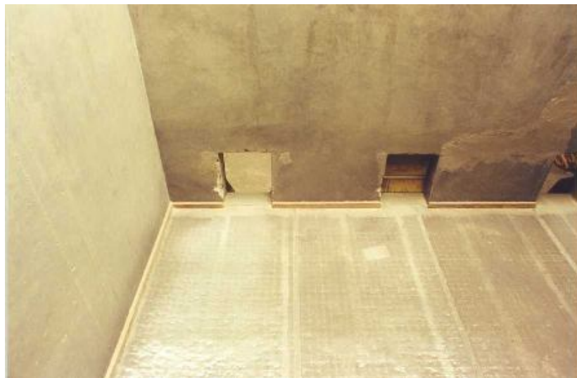
Figura. 1.5. Vista al interior de la cámara de secado de un sistema de secado en depósito en reposo (compuertas de vaciado).Puente de Ixtla Morelos (ARMOSA).
