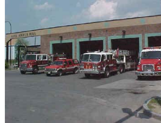
Estación de Bomberos Arbor Hill House, E. U. A.
