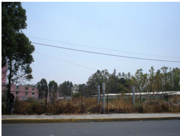
Vista del terreno en donde se puede apreciar la red eléctrica
