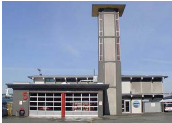
Estación de Bomberos Alaskan Way, Alabama, E.U.A.
