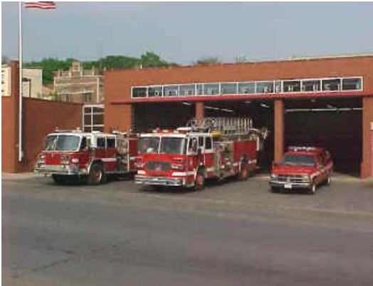
Estación de Bomberos South End, E. U. A.
