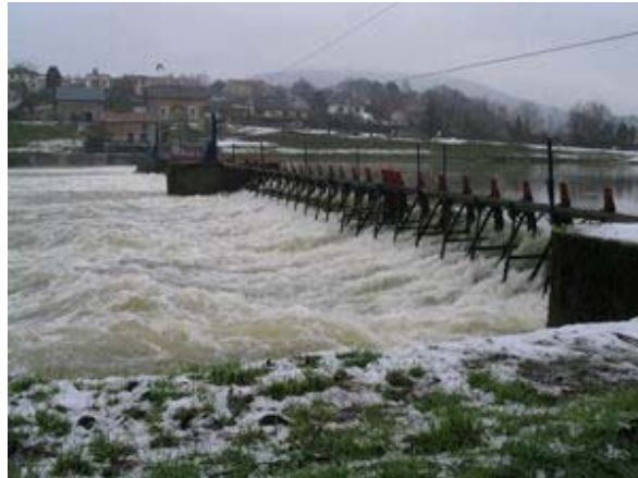
fig. 1.22 Presa de derivación en el río Moza
