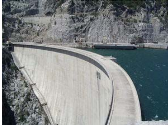
fig. 1.21 Presa en arco
