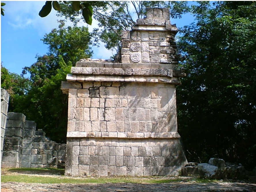
Fotografía 19. La Columnata Noreste. Fotografía tomada por el autor.
