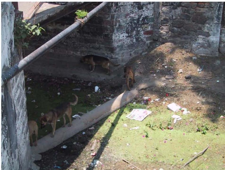
Condiciones actuales del “Canal Nacional”, muy próximo al embarcadero “Fernando Celada”, en el Barrio de “San Juan”. Debido a una incorrecta solución de drenaje, no existe continuidad en la navegación; por lo que el agua se estanca, no hay mantenimiento ni limpieza del canal.
