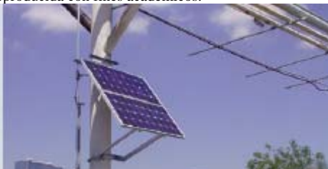
Figura 7.27 Módulos fotovoltaicos para uso en alumbrado público.
