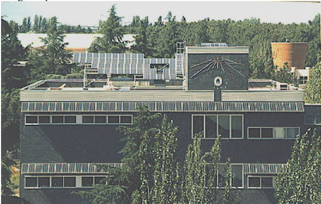
Figura 7.6 Uso de módulos fotovoltaicos como dispositivos de control solar. Además de generar electricidad, ofrecen el sombreado necesario en la construcción.
