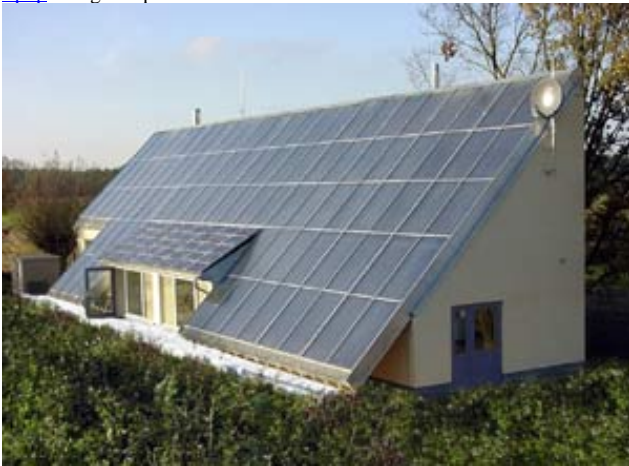
Figura 14.6. Las necesidades de energía térmica pueden requerir superficies de captación tales que pueden incluso requerir de toda la superficie de la cubierta.
