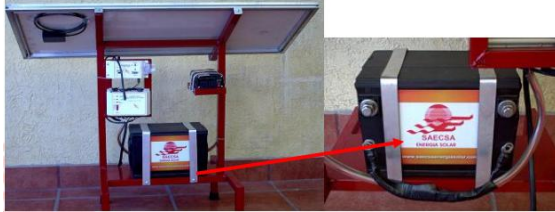
Figura 7.26 Baterías solares de ciclo profundo.
