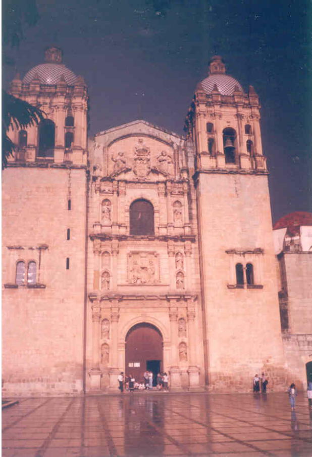
Figura 15.3 Las condiciones climatológicas y la orientación de este edificio permitieron obtener esta fotografía "nocturna" con luz natural. CRZ
