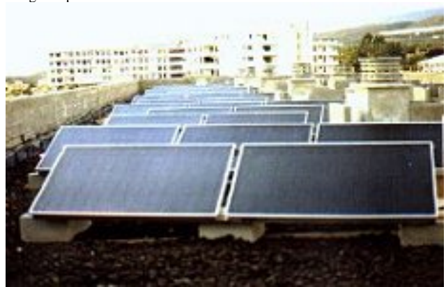
Figura 7.7 Disposición de paneles solares en azoteas y tejados.
