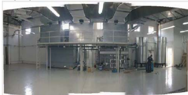
Figura 8.15 Unidad de enfriamiento. Máquina de absorción Guetermann-Polygal – Cuernavaca -México
