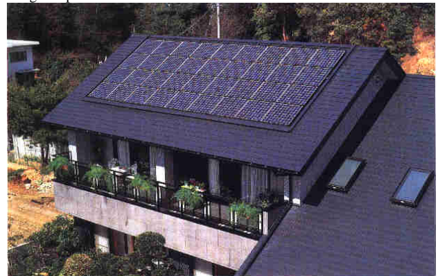
Figura 14.27 En un tejado solar las propias fotoceldas sirven de acabado a la cubierta en sustitución de las propias tejas.
