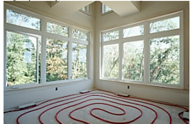
Figura 9.1 Montaje de tuberías y mangueras para calefacción por piso radiante.
