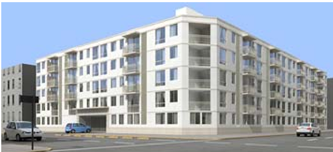
Figura 3.1 Edificio para oficinas
