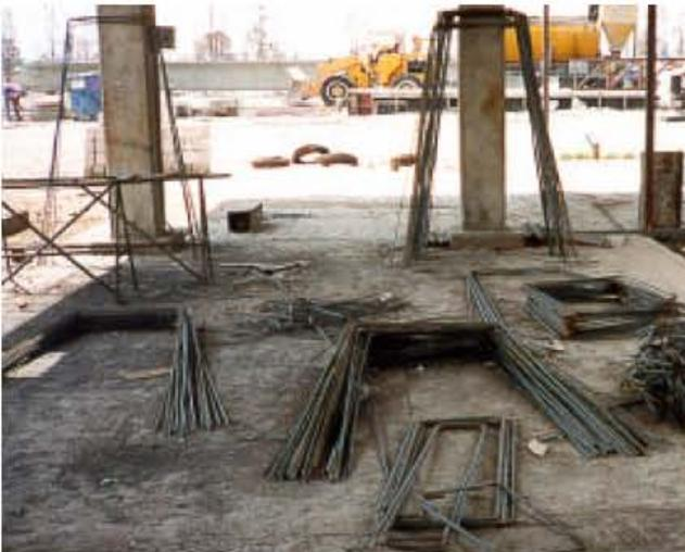
Vista de las instalaciones para almacenaje y preparación de acero en planta
