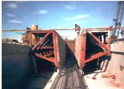
Tensado de cables. Proceso llamado, presfuerzo o pretensado de armado. Esto ayuda a que la pieza tenga una mayor resistencia al pandeo natural del peso de la misma, más el peso de las cargas que se transmitirán sobre ella.
