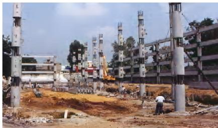
Colocación de columnas y trabes.
