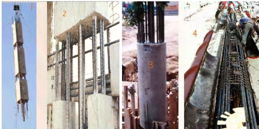
1. Columna prefabricada con sección cuadrada, izada y lista para su colocación.
