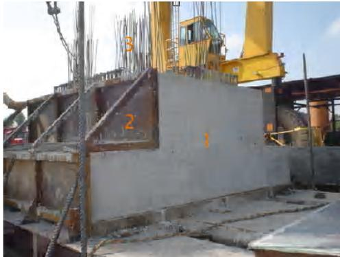
Zapata corrida prefabricada.
