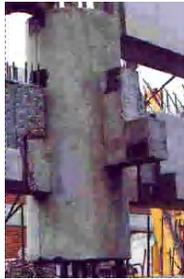
También a las columnas de sección circular y oblongas se les tiene que colocar sus respectivas partes de conexión para recibir a las trabes.
