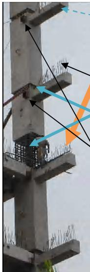
Aquí vemos que a las columnas se les puede agregar un brazo tipo sección de trabe "TPL" ó "T-Inv".
