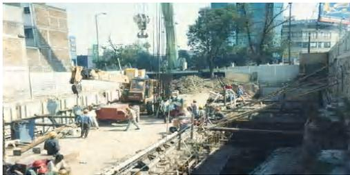
Preparación del terreno donde se colocará la grúa que ayudará a colocar los muros de contención prefabricados
