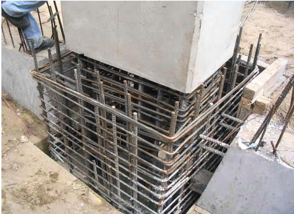
1. Unión de cimentación prefabricada, columna con sección rectangular prefabricada y contratraves prefabricadas, todos los armados se dejan sin colar para que posteriormente se coloque la cimbra y se inyecte GROUT.
