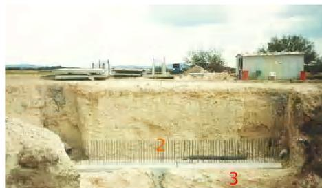
1. Colocación de una zapata prefabricada con aleros en forma angular.
