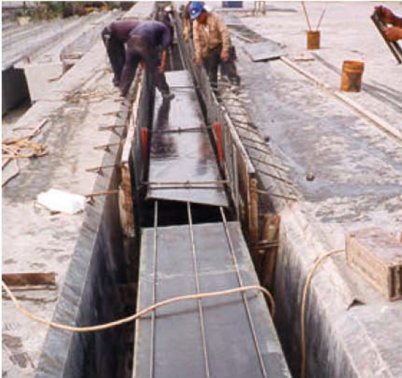
Molde de concreto para trabe cajón
