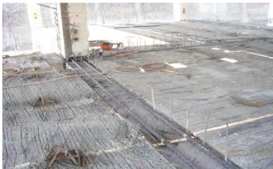
El colado complementario sirve para darle rigidez al sistema de manera horizontal, y para llegar al nivel de piso terminado a la edificación, en caso de estacionamientos y para dejar preparado el firme donde se colocaran los pisos especiales, como es el caso de los entresijos.
