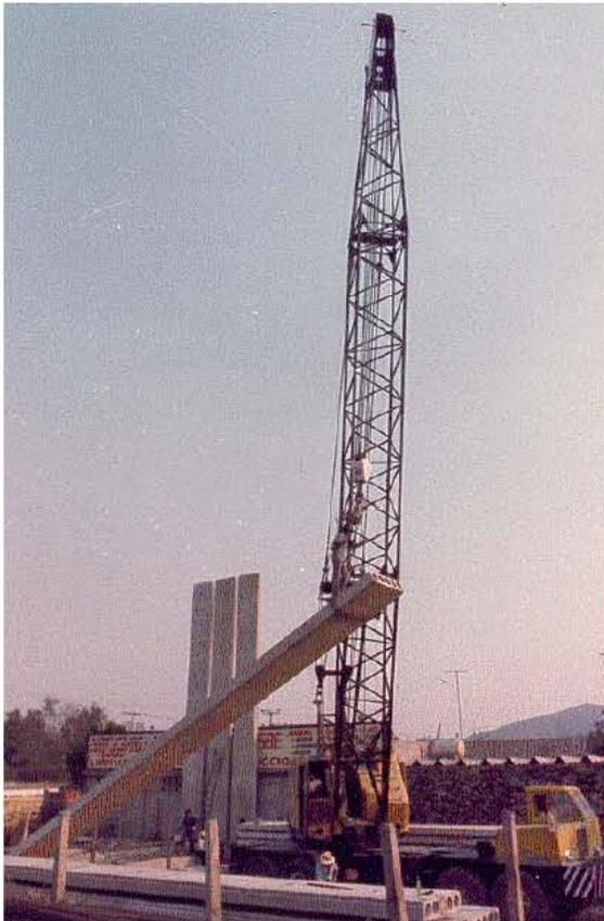
Montaje de columnas en candelerero
