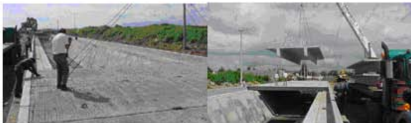
Fig. 2.12 Construcción del drenaje pluvial. (Sadasi, 2006)
