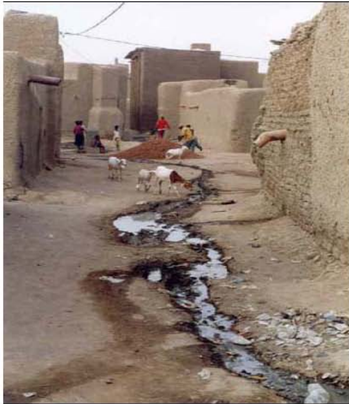
Fig. 2.5 Calle contaminada en Djenné debido a las descargas de las tuberías por donde eran desalojadas las aguas negras. (Alderlieste, 2004)
