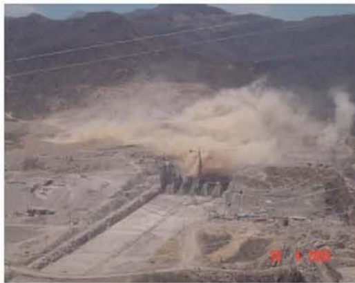
Figura 3.3 Construcción de la presa “El Cajón” en Nayarit.
