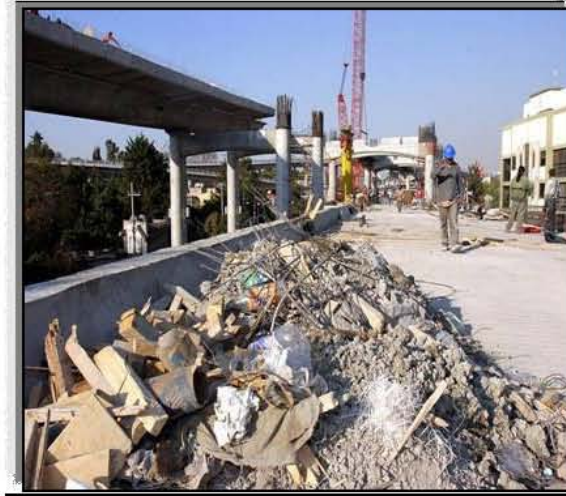
Figura 3.6 Construcción del 2º piso del periférico, D.F.
