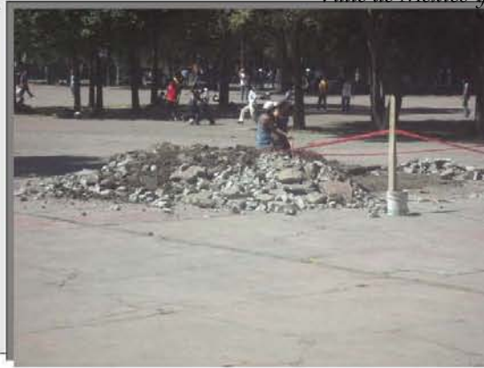
Figura 3.9 Obras de mantenimiento
