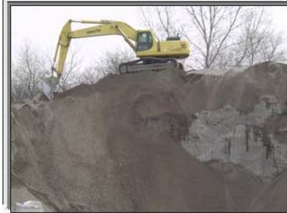
Figura 3.2 Extracción de material en banco
