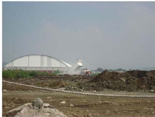
Figura 3.32 Disposición de RESIDUOS C&D con trailer
