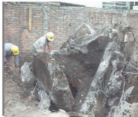
Figura 3.7 Trabajos de demolición
