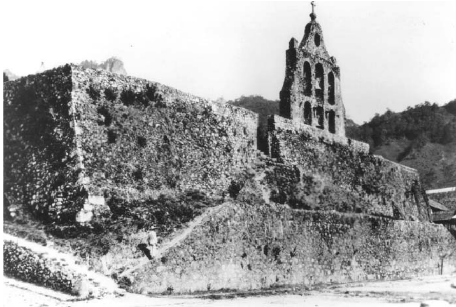
Estado en que se encontraba el acceso al conjunto conventual de molando en la primera mitad del siglo pasado; fotografía tomada antes de realizar los trabajos de reconstrucción.
