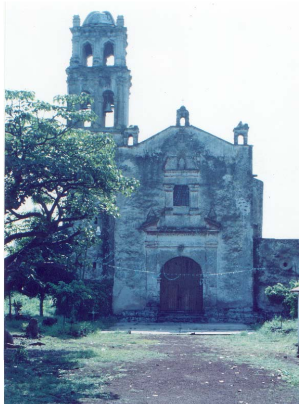
Portada Principal del ex-convento en la población de Pazulco dentro del actual Estado de Morelos. Esta casa fue un pequeño convento el cual contaba con tres locales (pudiendo ser uno para la sacristía y dos celdas), claustro, derruidos en gran parte en la actualidad, cuenta también con su atrio así como con su arcada real, estando bardado en su totalidad.
