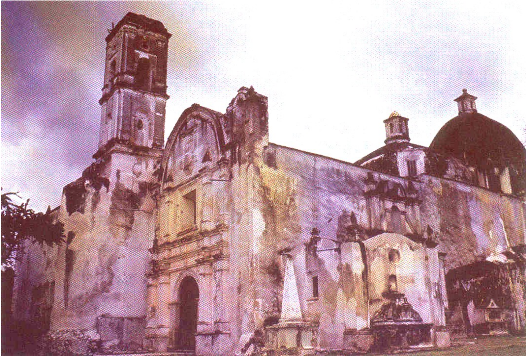
Templo de Jonacatepec con advocación a San Agustín. Construcción realizada en la segunda mitad del siglo XVI. La portada está realizada en argamasa no obstante que en el lugar existen bancos de piedra (en su momento esta población dotó de cantera para la edificación del convento de Yecapixtla, ya que era tributario del mismo).
