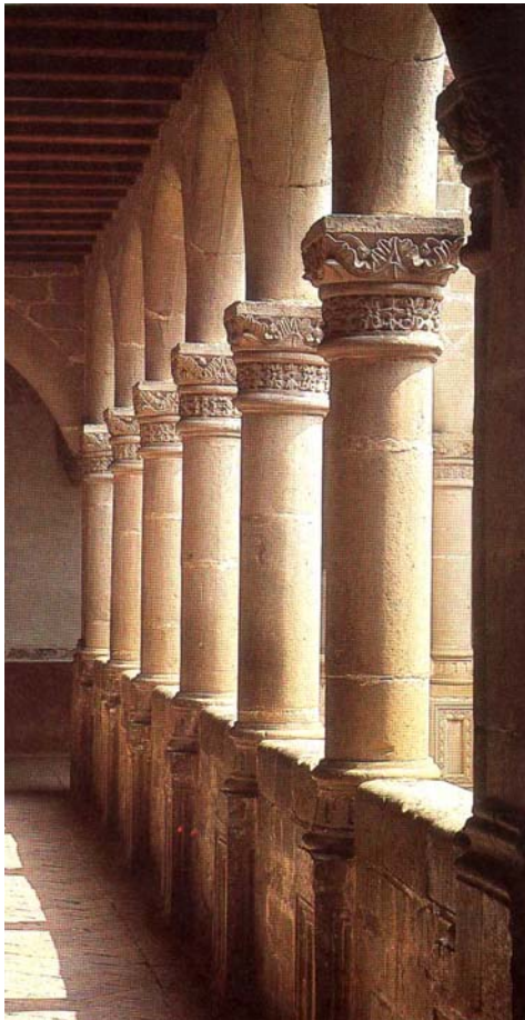
Vista de un ambulatorio del primer piso en uno de los claustros del exconvento de Acolman, en donde podemos apreciar el contraste entre el refinamiento logrado y la masividad y rudeza del conjunto.
