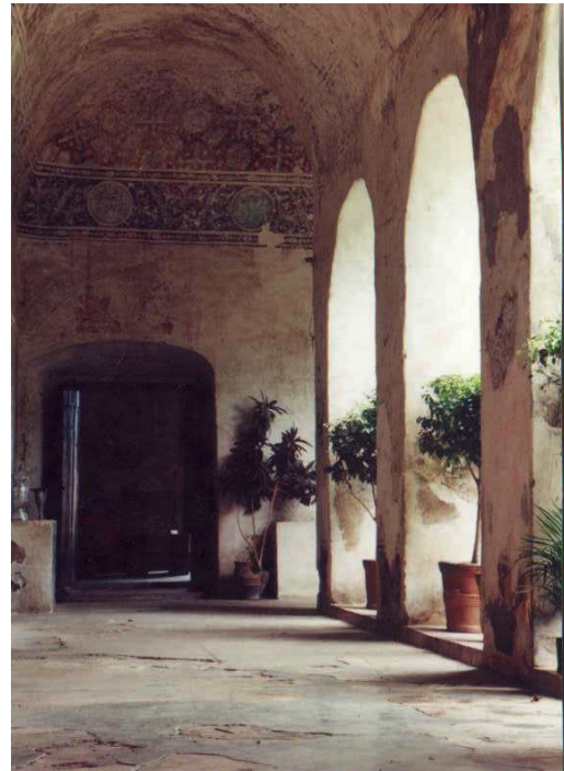
Fotografía tomada 76 años después en el mismo lugar en la cual podemos observar los vestigios de los frescos y grisallas después de haberse retirado el encalado de los muros. Así mismo se aprecia que los vanos bajo los arcos fueron vaciados.
