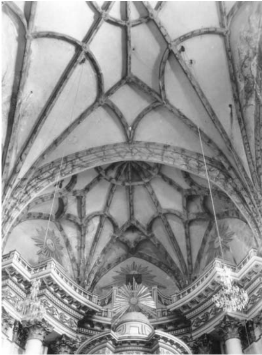
Documento fotográfico el cual nos muestra el ábside del templo, en el cual podemos observar el extraordinario trabajo realizado en las bóvedas de pañuelo nervadas así como el remate del baldaquín neoclásico.
