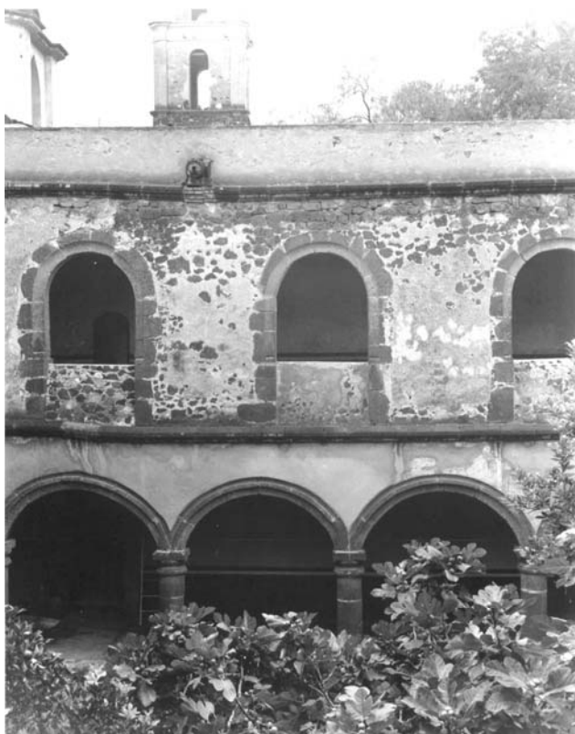
Documento fotográfico tomado del claustro alto en el cual podemos observar el trabajo de cantería, siendo este de una factura bastante sencilla, tal vez debido al material empleado para su elaboración (piedra basáltica).
