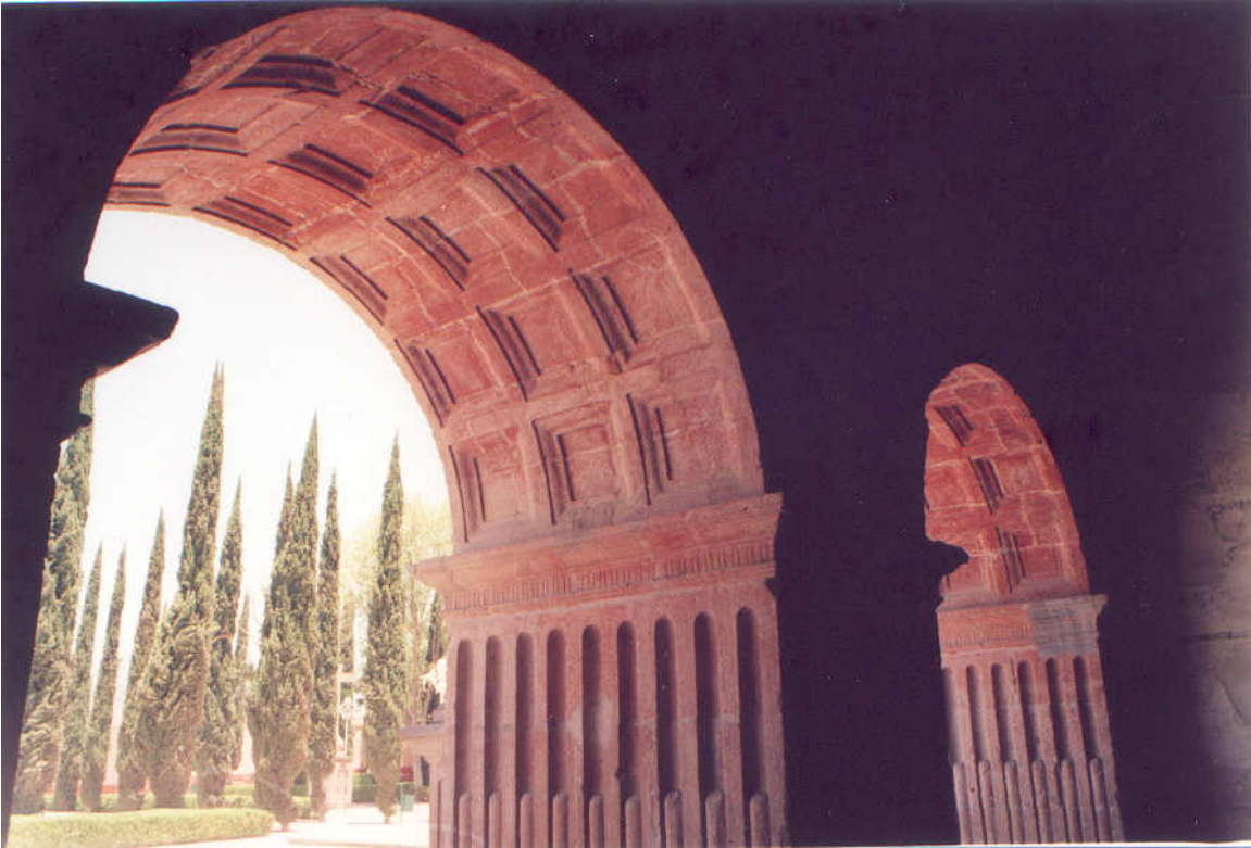
(Fig. No. 9) Vista del interior desde el pórtico o portal de indios hacia el atrio. En la cual se puede apreciar la gran influencia de la arquitectura románica, con los arcos de medio punto estando las arquivoltas con casetones, además podemos apreciar el extraordinario trabajo de cantería logrado por la mano de obra indígena.
