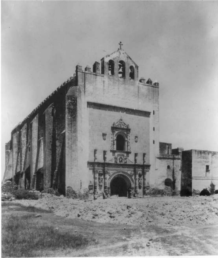
Estado en que se encontraba el conjunto conventual de Acolman en el año de 1925 antes de iniciar los trabajos de rescate del monumento.
