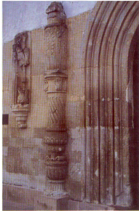
Documento fotográfico el cual nos muestra el detalle de la portada del templo del Señor Santiago en el cual podemos observar parte de lo que fuera una de las columnas candelabro que flanqueaban al acceso del templo; así como otro detalle de ornamentación de la portada.
