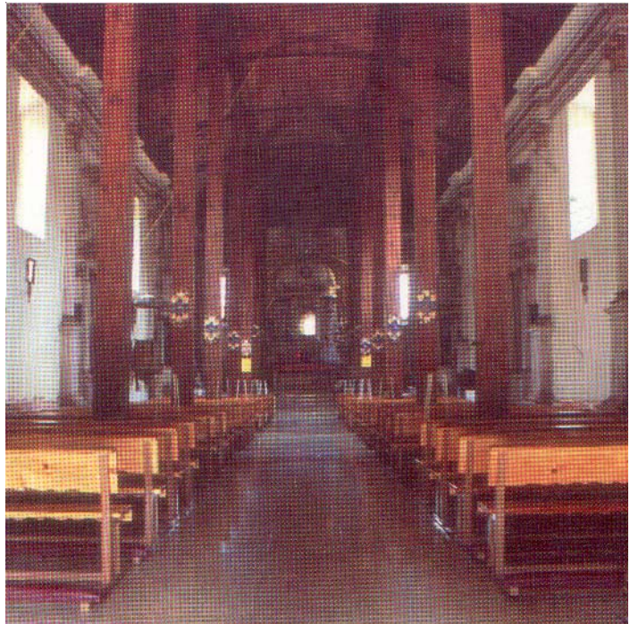
Interior del templo del exconvento de Tiripitío, en donde se pueden apreciar las columnas de madera intermedias, sobre las cuales se apoyan las estructuras de tijera base de la cubierta de madera. Reproducción obtenida del libro Esplendor de la Arquitectura Novohispana.
