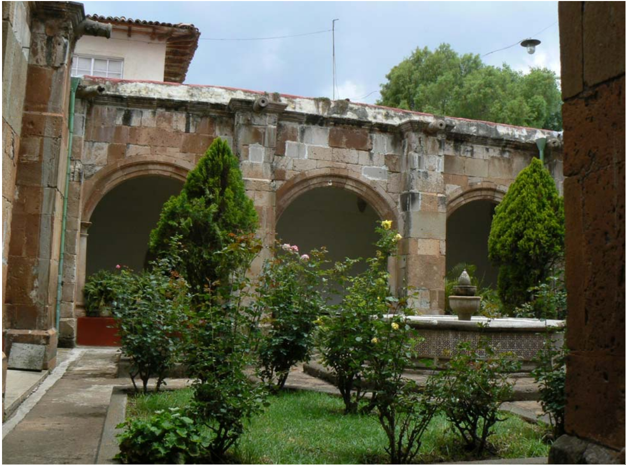
Claustro del que fuera convento en la población de Huango. Convento de un piso el cual nos muestra una planta cuadrangular con cuatro arcos, arcos de medio punto asentados sobre medias columnas cuadradas adosadas a voluminosos elementos rectangulares como si fueran contrafuertes similares a las primeras edificaciones de la orden en la Nueva España.
