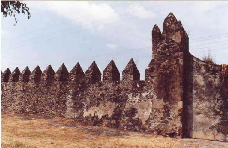
Documento fotográfico de una barda atrial rematada con almenas como remate y garitrón estilizado. Barda perteneciente al ex-convento de Yecapixtla.
