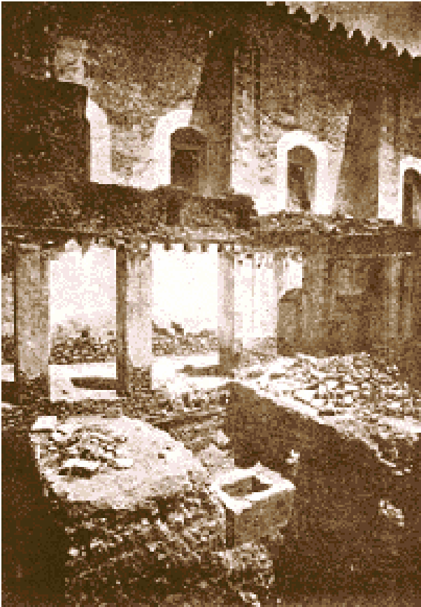
Otro valioso documento histórico fechado para el año de 1925, en el cual se pueden apreciar los primeros trabajos de recuperación del monumento; siendo estos los del desazolve del primer claustro (claustro chico o franciscano).
