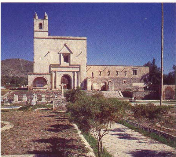
(fig. No. ) Fachada poniente del ex-convento de Epanzoyucan en el cual podemos observar al lado izquierdo la capilla abierta de una gran sobriedad pero de dimensiones bastante modestas en contra de monumental capilla abierta del ex-convento de Actopan.
