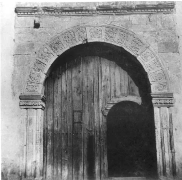
Acceso al templo de Santa Catarina . en el cual se observa el bajorrelieve de las dobelas del arco de medio punto el cual descansa sobre columnas.
