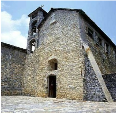
Vista del templo de San Pedro de Chililita, en el cual se puede observar contrafuerte para soportar la estructura.
