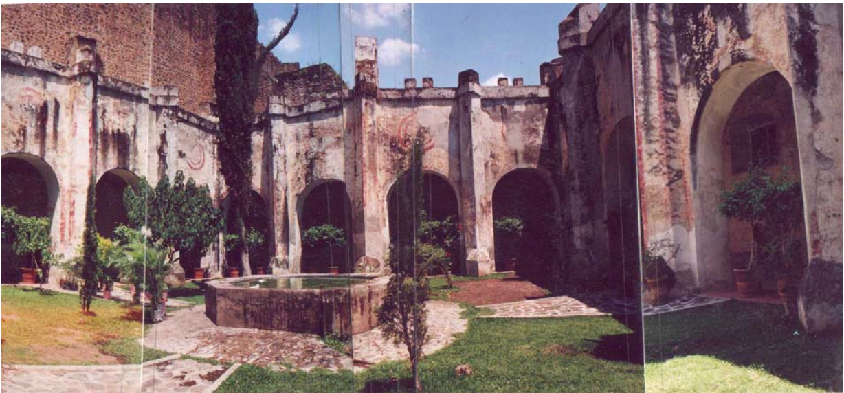
Claustro del ex convento de Yecapixtla, con advocación a San Juan Bautista. Este es uno de los claustros denominado por Kubler como de los "Claustros de Contrafuerte"; en el cual se puede observar que el claro libre resultante es mínimo con los realizados posteriormente, obsérvese la relación entre las pilastras con contrafuertes de gran espesor y volumen con espacio logrado por el arco de medio punto. Se puede observar el recurso obtenido para el mayor paso de luz con un discreto adiamantado en los contrafuertes.
