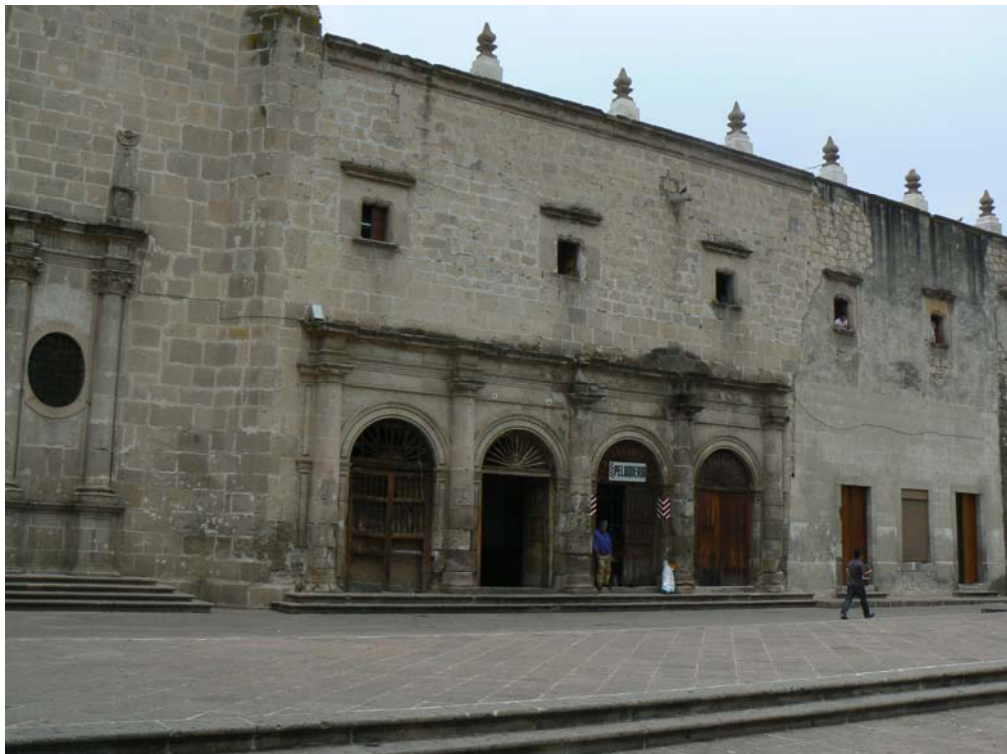
Tramo sur de la fachada principal del conjunto conventual de Santa María de Gracia; en ella vemos el portal ahora con una cancelería de madera, mas a la izquierda se aprecian las alteraciones que ha sufrido el monumento al abrírsele tres vanos. En el primer piso se aprecian cinco ventanas de igual número de celdas.
