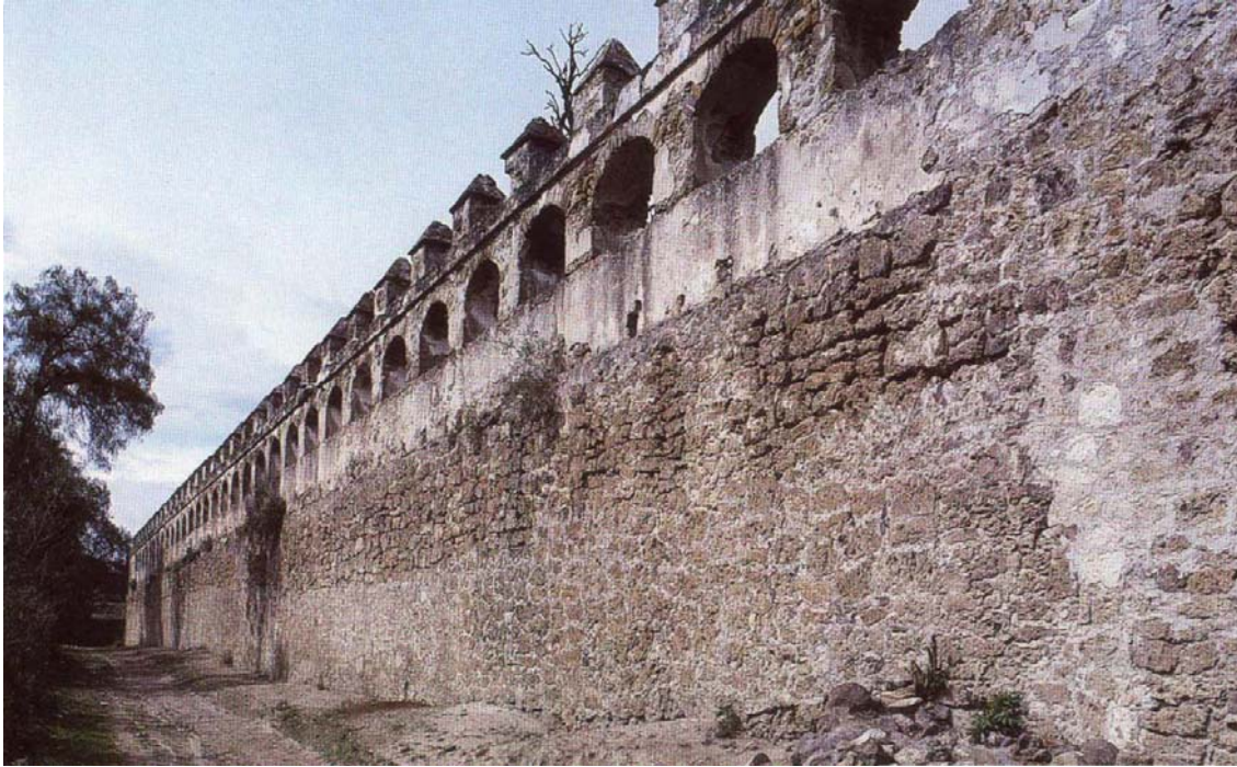
Barda que delimita el atrio del templo franciscano de Cuauhtinchan, el cual esta compuesto por una arcada rematada con almenas. En este caso se puede observar claramente que las almenas elementos creados para edificaciones fortificadas no son utilizadas con ese fin ya que estas están colocadas sobre una arcada.
