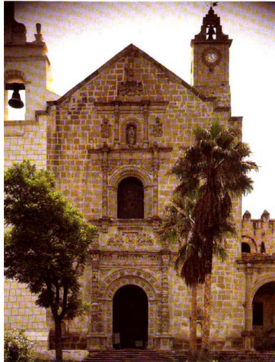
Documento fotográfico el cual nos muestra la portada del exconvento de Cuitzeo de la Laguna. En la cual se pueden ver las dos torres campanario realizadas posteriormente.
