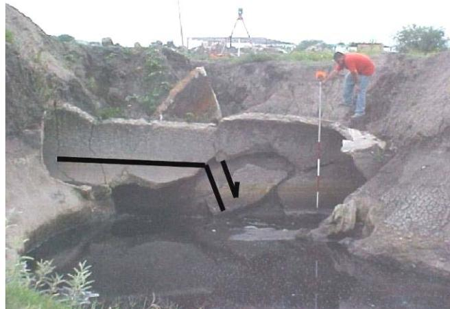
Figura 6.8 Fallamiento Vanegas flanco oriente en la zona de Santa María Magdalena. Ubicación del sitio mostrado en figura 6.5.
