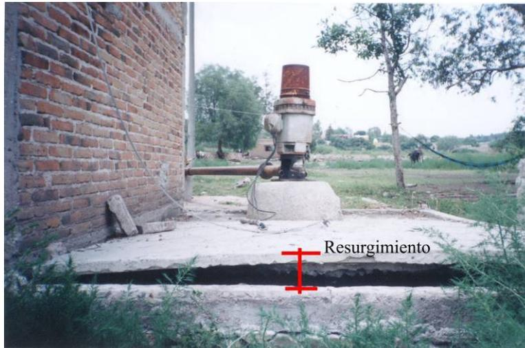
Figura 6.3 Resurgimiento de un pozo en el rancho “Tres Ciénegas”.
