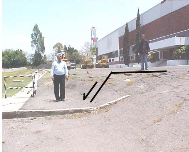
Figura 6.6 Fallamiento 5 de Febrero en el predio de la antigua planta Singer, el cual en 2004 presentaba un desplazamiento vertical de cerca de un metro. Ubicación del sitio mostrado en figura 6.5.
