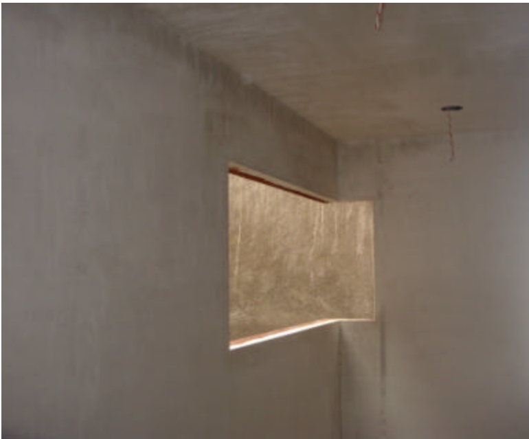
Yeso en recamara
