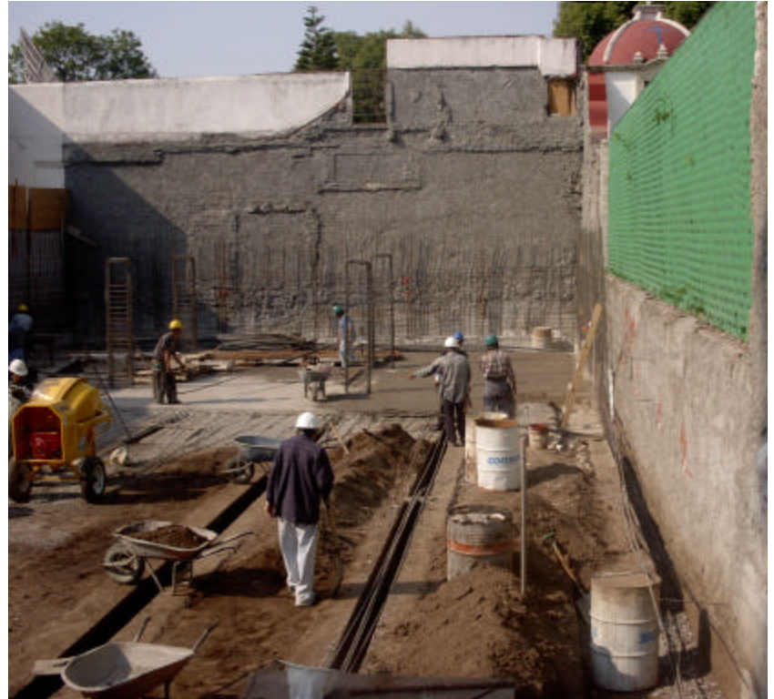
Vista interior del terreno de norte a sur.
