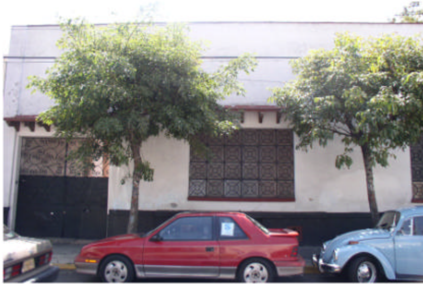
Fachada del predio
