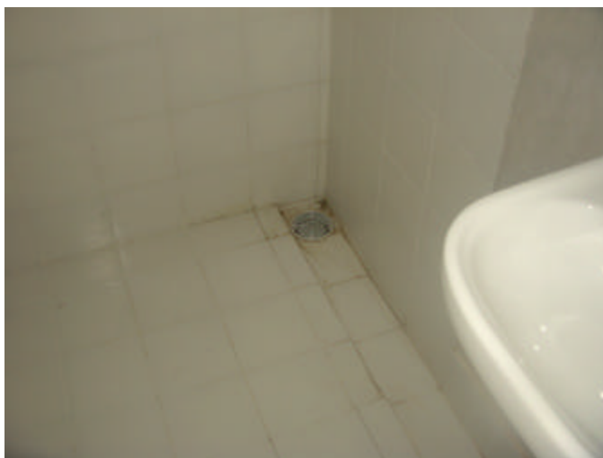
Área de regadera en baño de servicio.
