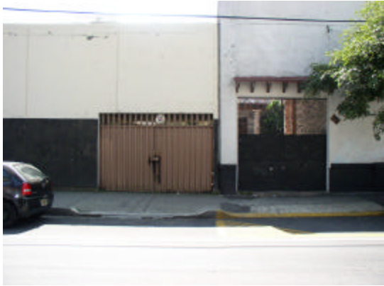
Fachada colindancia Oriente
