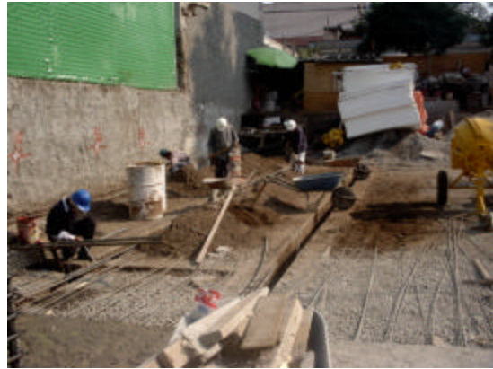
Foto interior vista de sur-norte; se observa la realización de la excavación de cepas y el acarreo del material sobrante. (colindancia poniente)
