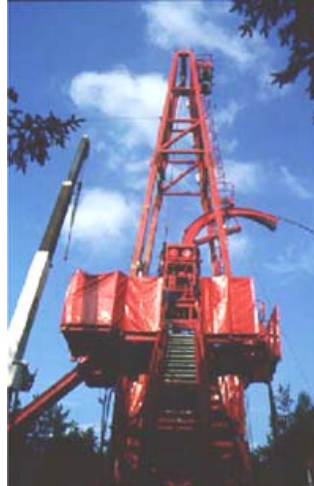
Figura IV.14. Equipo Aleman Nowsco para Perforar con T.F. 2
