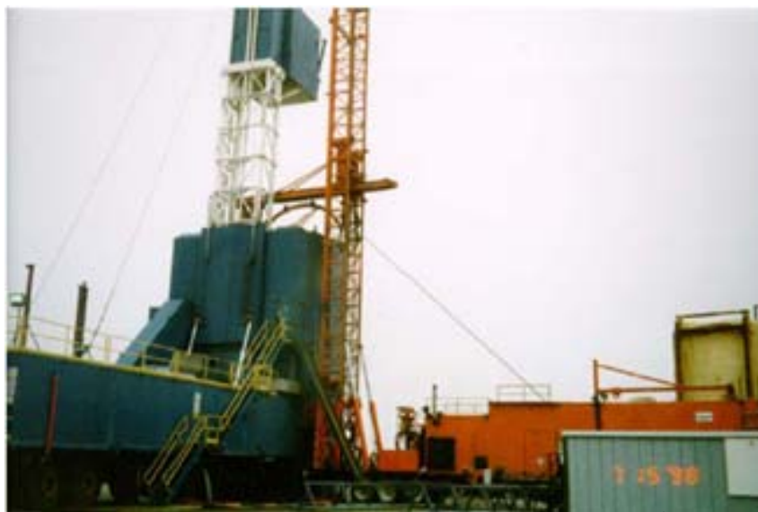
Figura IV.24. Equipo Arco para Perforación con T.F. 2
