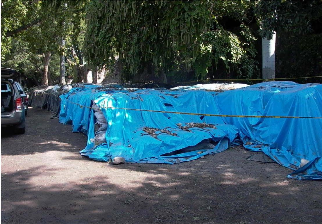
**FOTOGRAFÍA 3.** Patio de Hacienda en donde se observa la tierra extraída para su posterior confinamiento
