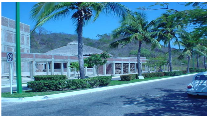
Vista del área de pórtico y concesiones en obra negra
