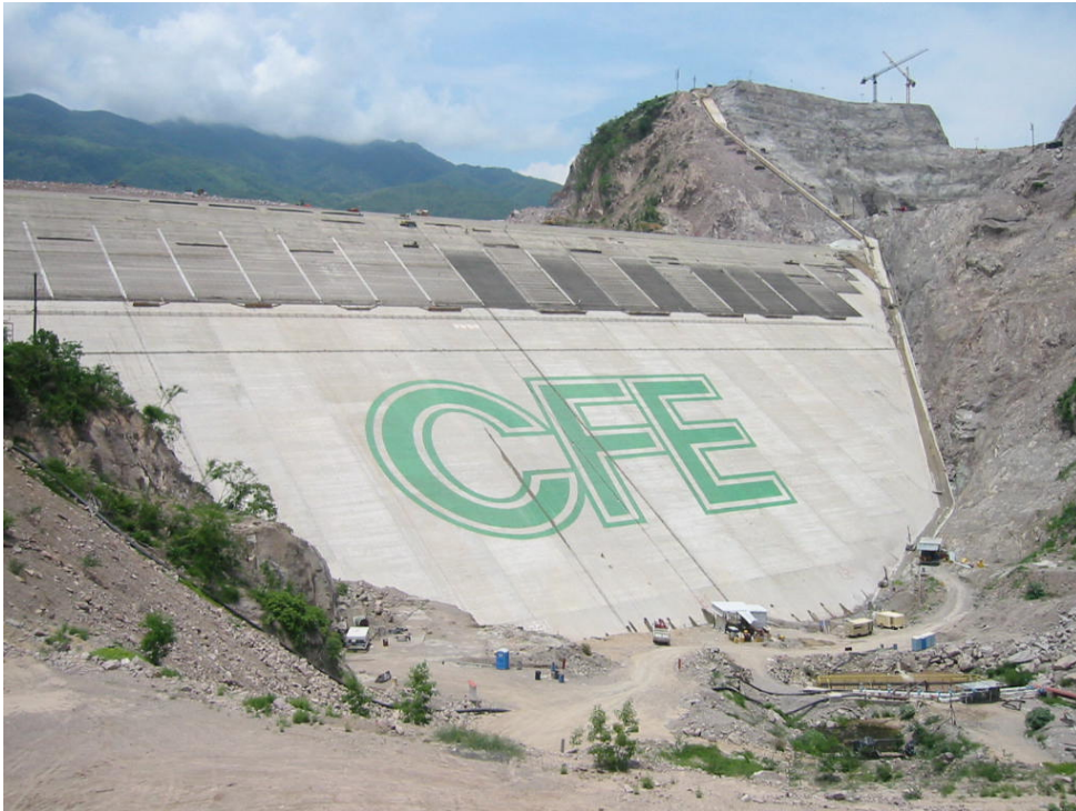
FIGURA 2.7 OBRA DE CONTENCIÓN CON CARA DE CONCRETO
