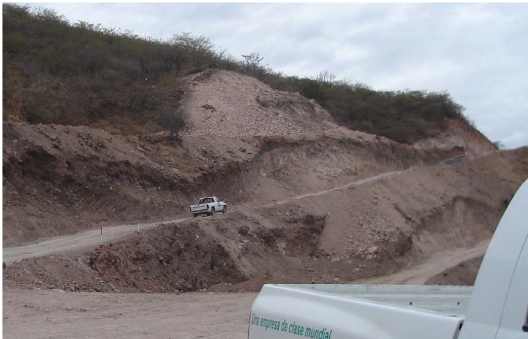
FIGURA 3.7 ESTADO ACTUAL (EN CONSTRUCCIÓN) DEL CAMINO AL P. H. LA YESCA
