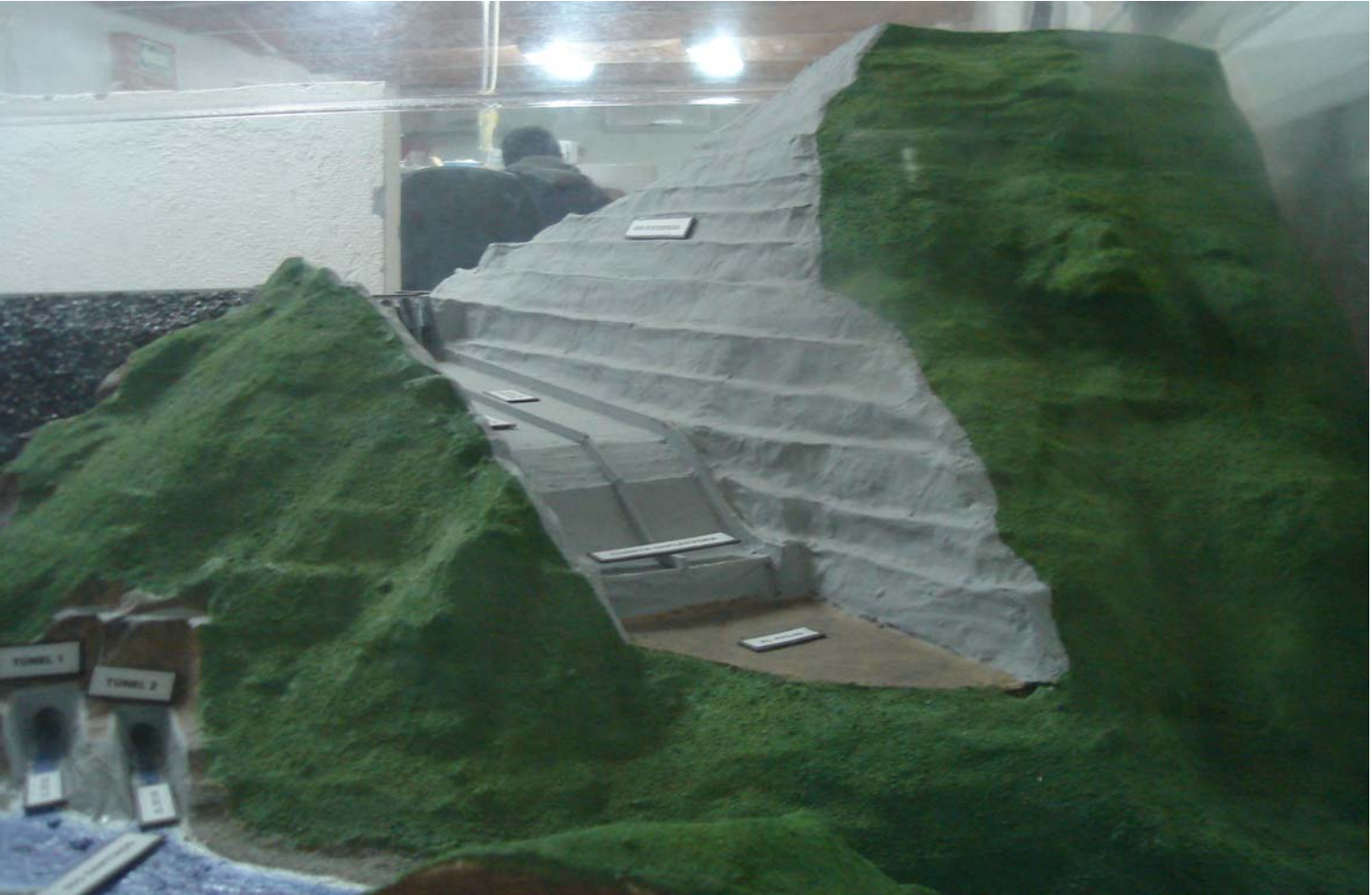
FIGURA 2.25 OBRA DE EXCEDENCIAS
