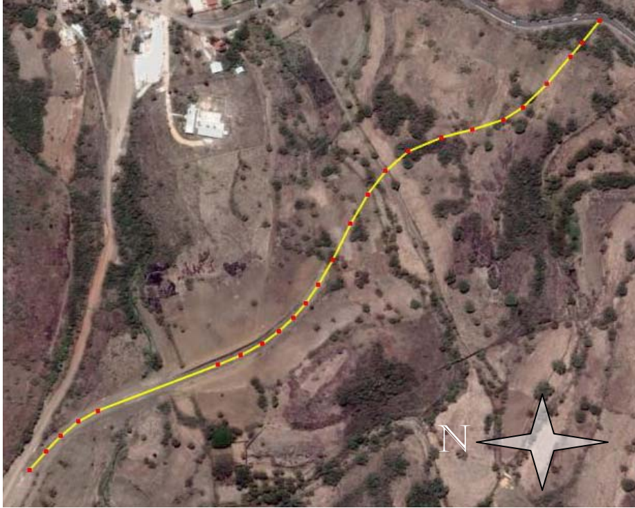
FIGURA 3.9 TRAZO DEL LIBRAMIENTO SOBRE EL TERRENO. EN LA PARTE IZQUIERDA SE ALCANZA A NOTAR PARTE EN CONSTRUCCIÓN.
