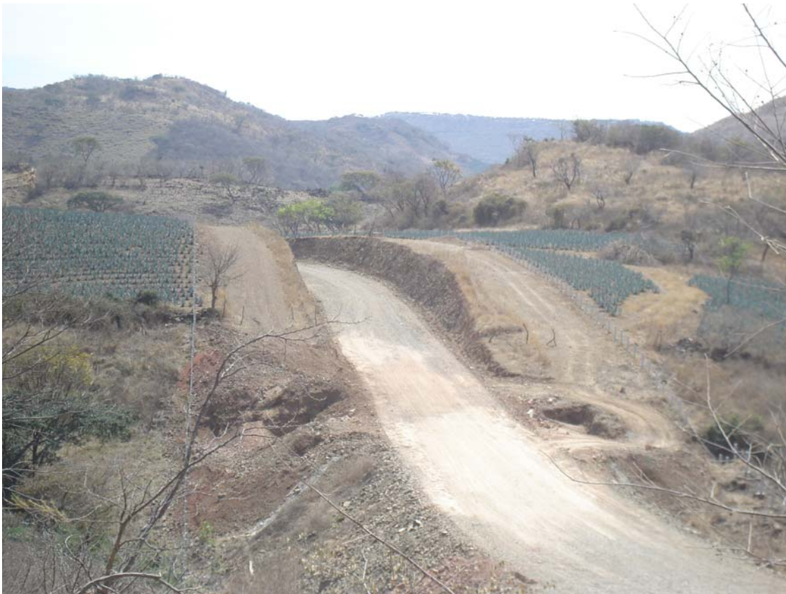
FIGURA 4.28 CAMINO TERMINADO Y DELIMITADO
