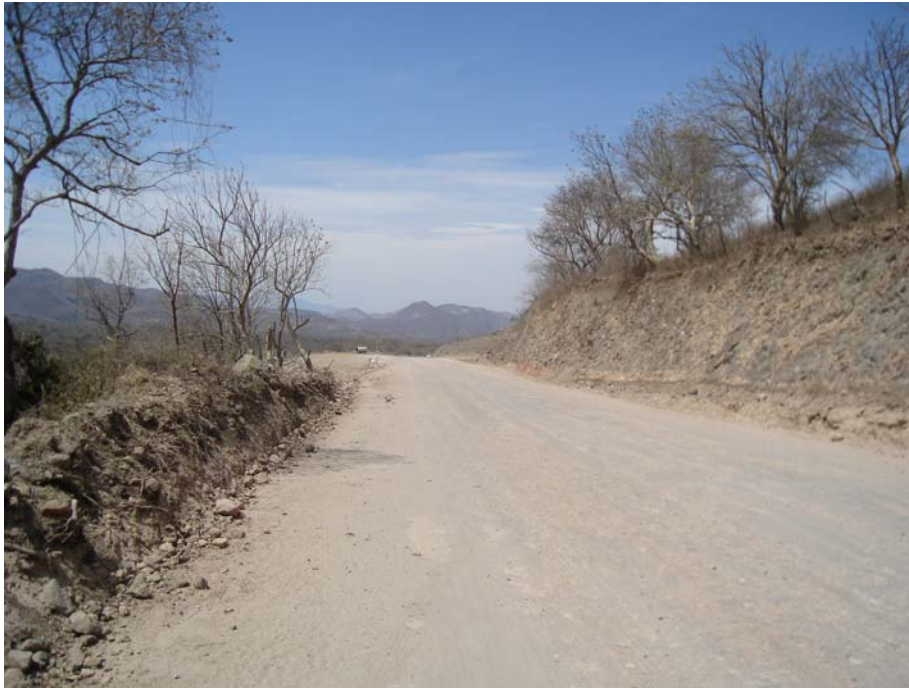
FIGURA 4.29 TERRACERÍA BIEN COMPACTADA Y TERMINADA
