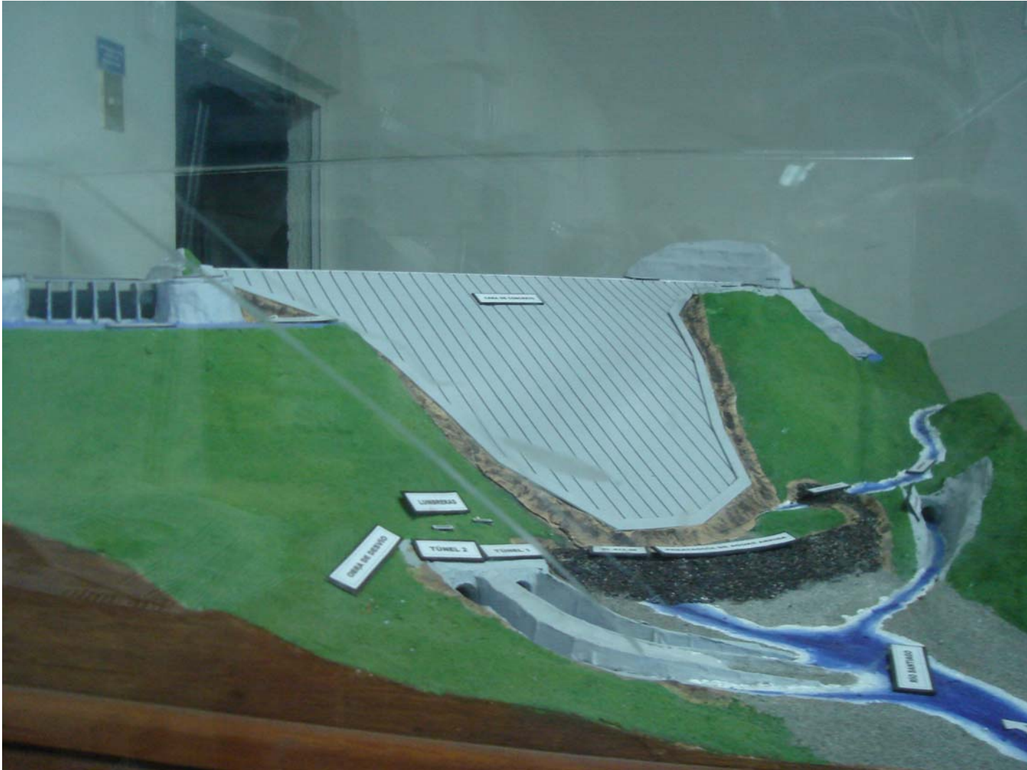
FIGURA 2.22 CARA DE CONCRETO, ATAGUÍAS AGUAS ARRIBA Y TÚNELES DE DESVÍO
