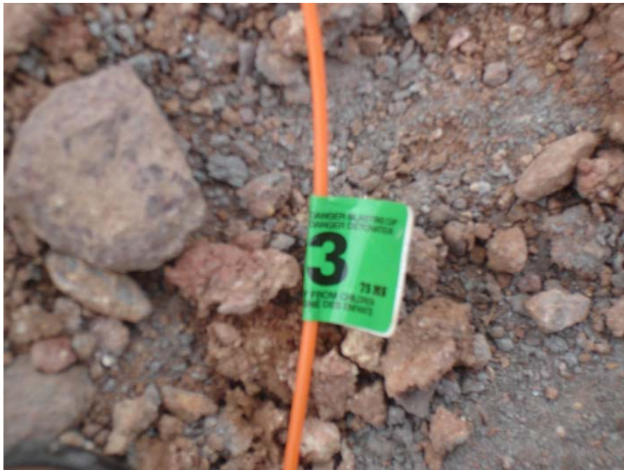
FIGURA 4.15 CADA EXPLOSIVO TIENE UN TIEMPO PARA DETONAR DESPUÉS DE SER ACCIONADO Y UN NÚMERO PARA SU REFERENCIA. EN LA IMAGEN SE NOTA QUE ES EL TERCER EXPLOSIVO Y DETONARÁ 75 MILISEGUNDOS DESPUÉS DE SER ACTIVADO POR EL CONTEO REGRESIVO.
