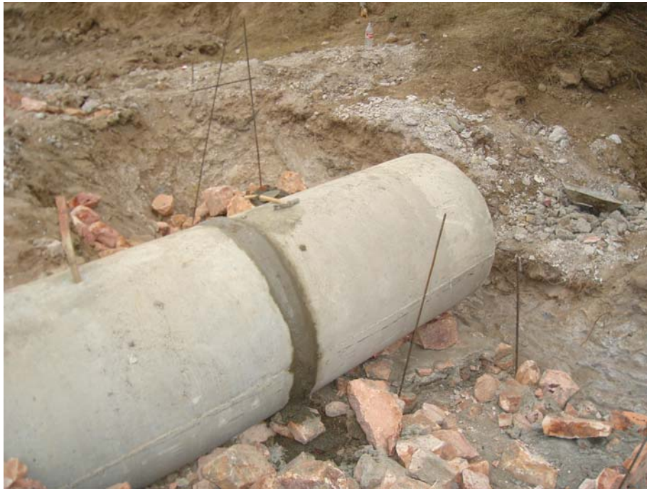
FIGURA 4.24 CONSTRUCCIÓN DE ALCANTARILLAS CON TUBOS DE CONCRETO Y JUNTA DE CEMENTO
