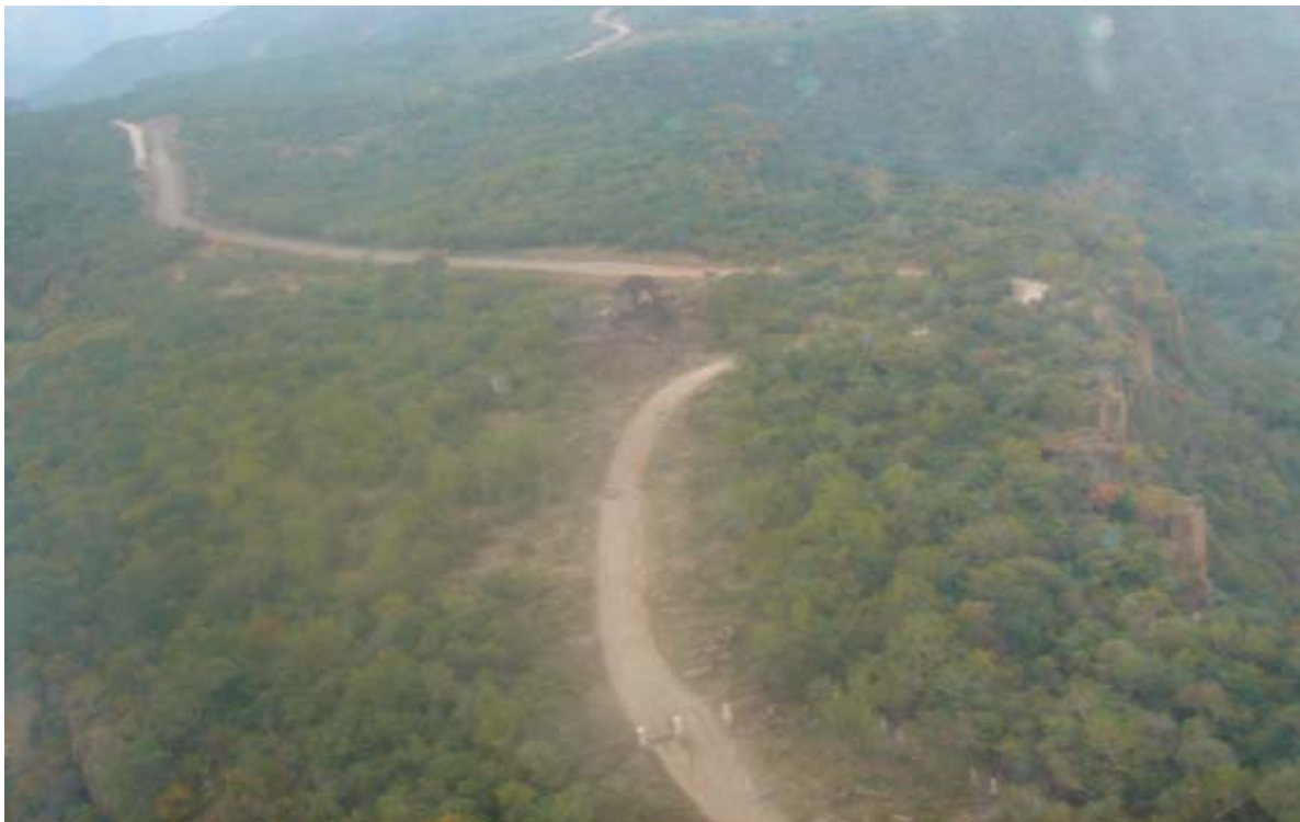
FIGURA 3.11 ESTADO ACTUAL DEL CAMINO DE ACCESO. FOTOGRAFÍA AÉREA SE OBSERVA CURVA MUY CERRADA
