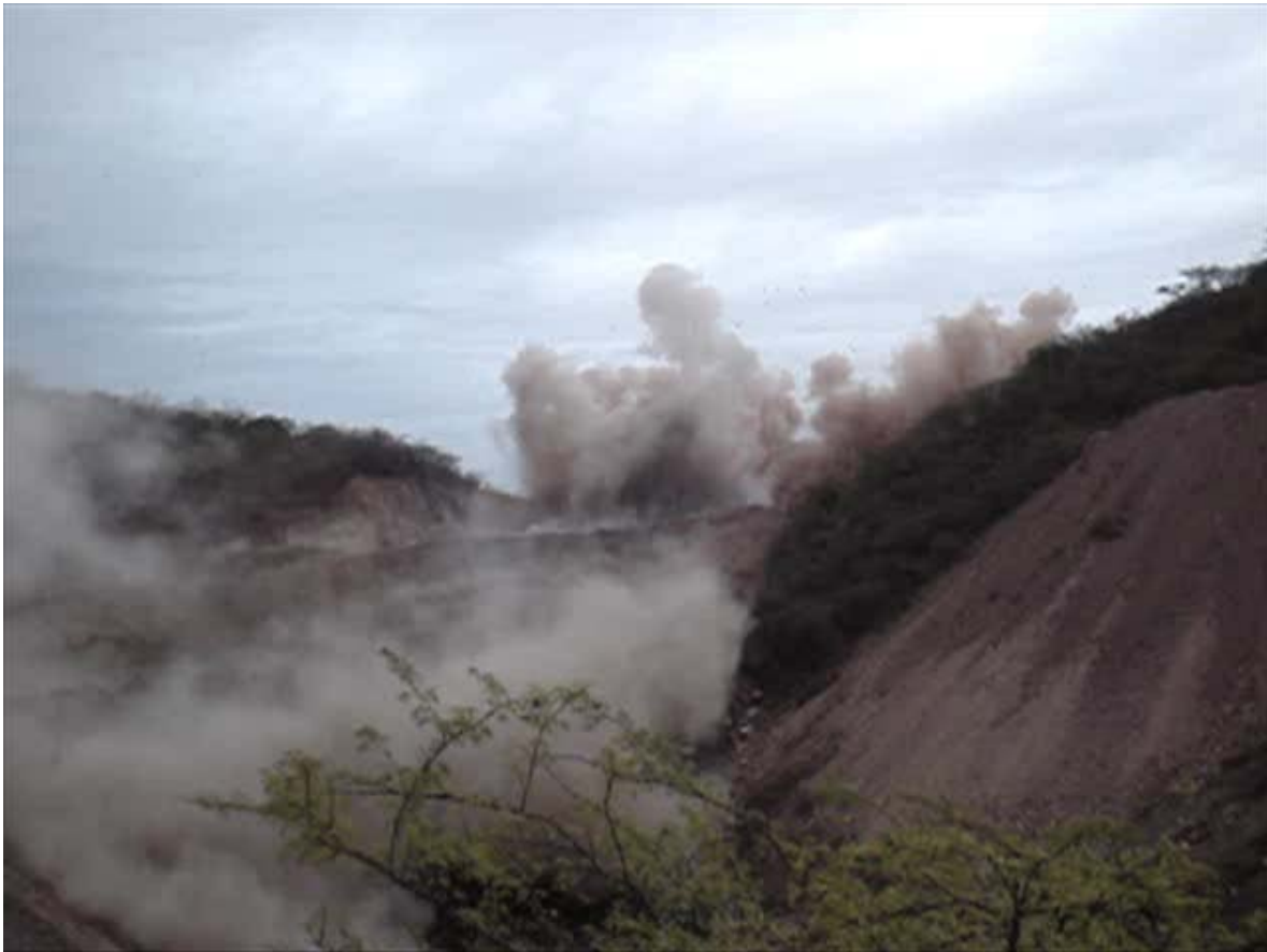
FIGURA 4.18 SE PRODUCE LA VOLADURA (FRAGMENTACIÓN DEL MATERIAL)
