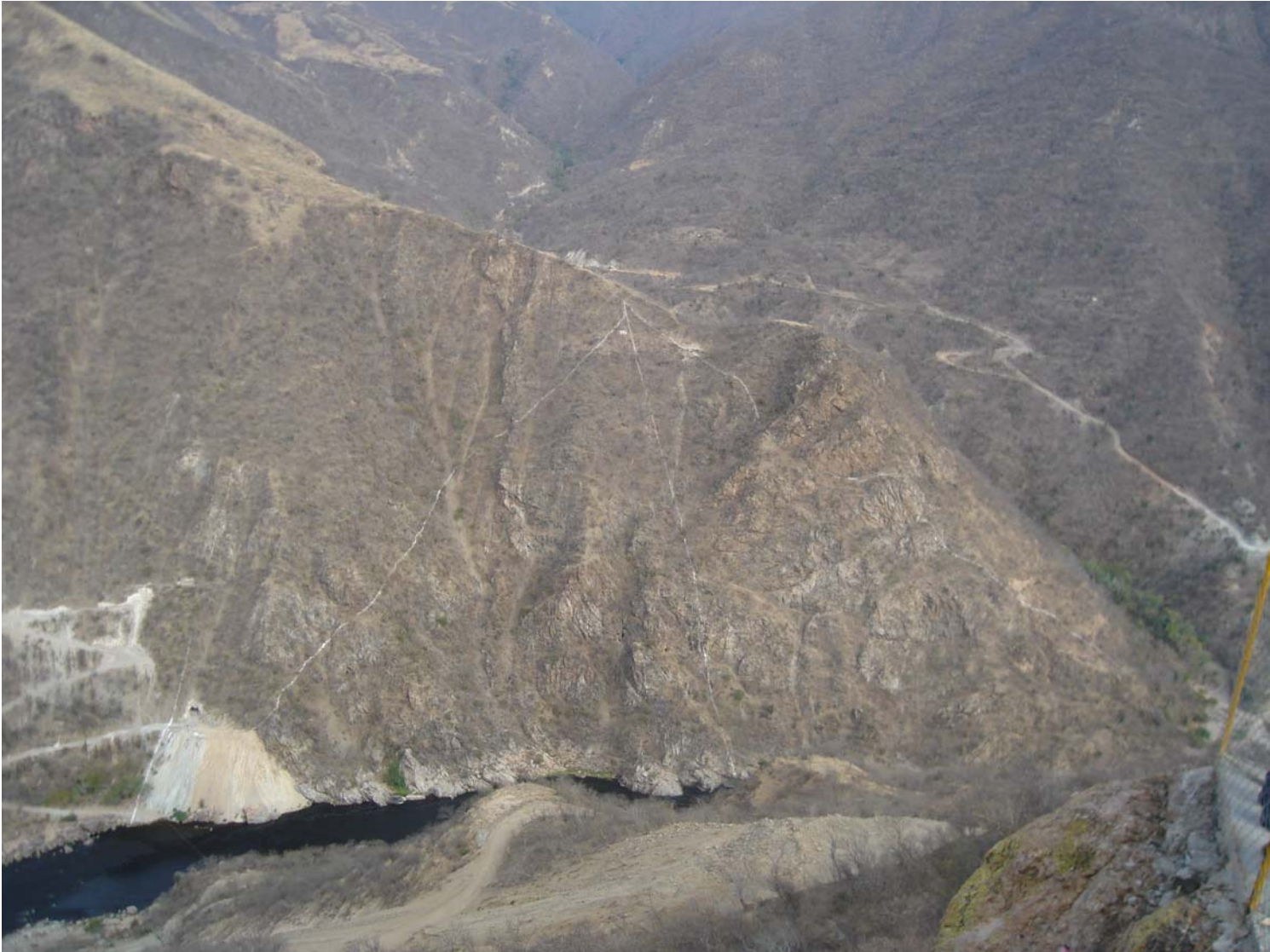
FIGURA 2.17 FOTOGRAFÍA DEL TRAZO DONDE SE ENCONTRARÁ LA CORTINA. ABAJO UN SOCAVÓN
