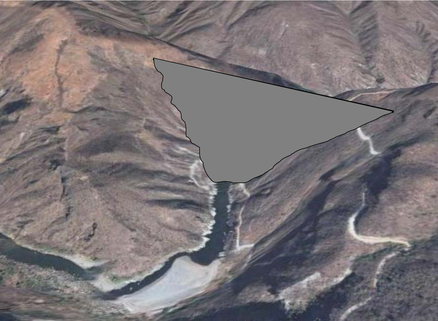
FIGURA 2.14 FOTOGRAFÍA SUR-NORTE CON REPRESENTACIÓN DE CORTINA. VISTA DESDE EL ENROCAMIENTO
