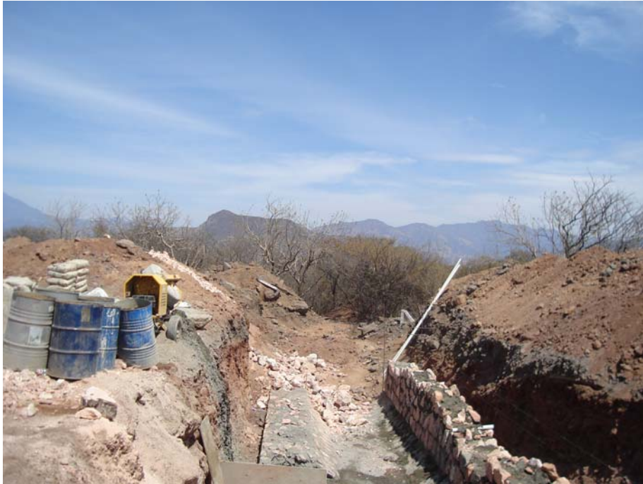
FIGURA 4.26 CONSTRUCCIÓN DE PASO GANADERO CON MUROS DE MAMPOSTERÍA
