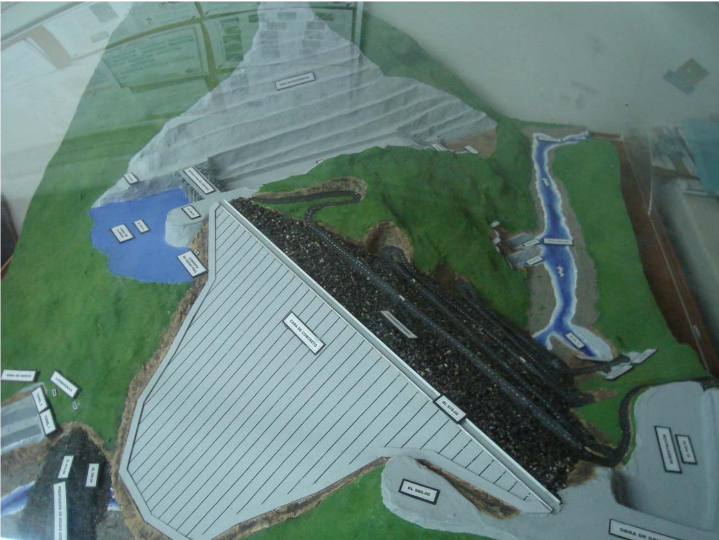
FIGURA 2.23 VISTA SUPERIOR. CARA DE CONCRETO, ENROCAMIENTO Y OBRA DE EXCEDENCIAS
