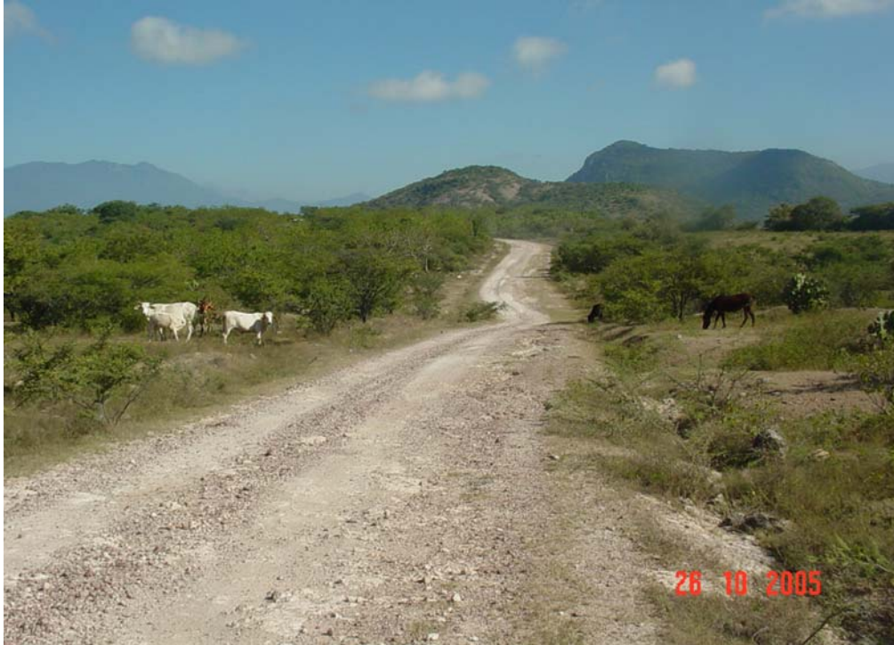
FIGURA 3.10 ESTADO ACTUAL DEL CAMINO DE ACCESO. TRAMO DE UN SOLO CARRIL
