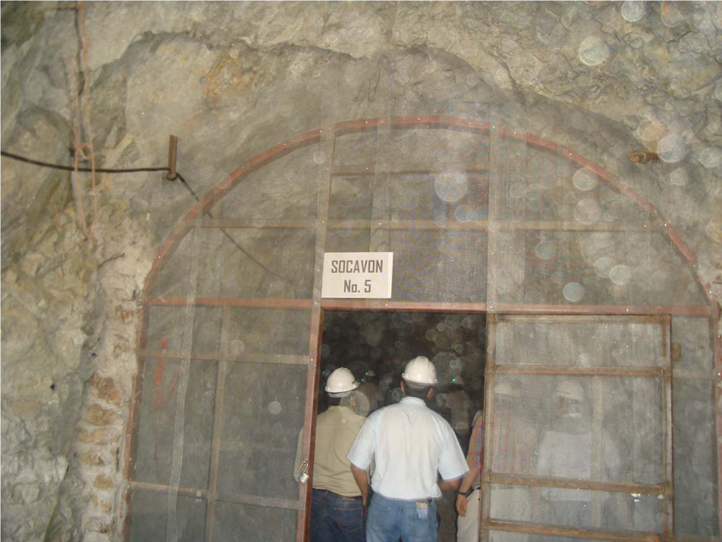
FIGURA 2.19 ENTRADA AL SOCAVÓN NO. 5
