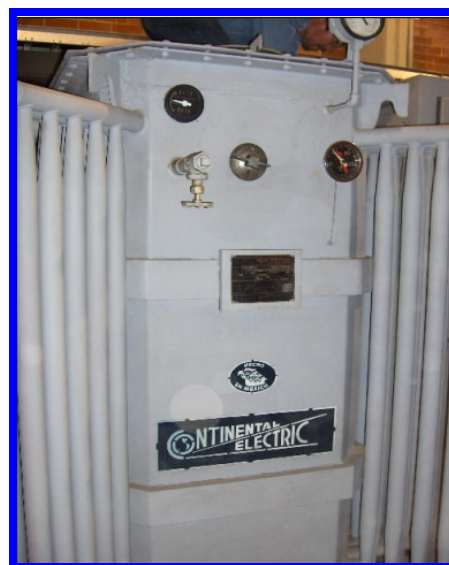
Fotografía 7 y 8. Transformador de 550 kVA ubicado en Instituto de Ingeniería, a la derecha se muestra un transformador de 500 kVA ubicado en la Facultad de Química Edificio "B".
