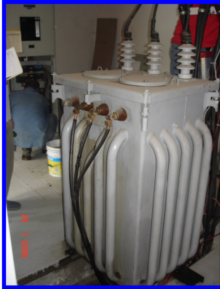
Fotografía 5 y 6. Transformador de 112.5 kVA ubicado en Instituto de Ingeniería, a la derecha tenemos un transformador de 300 kVA ubicado en la Facultad de Derecho Biblioteca.
