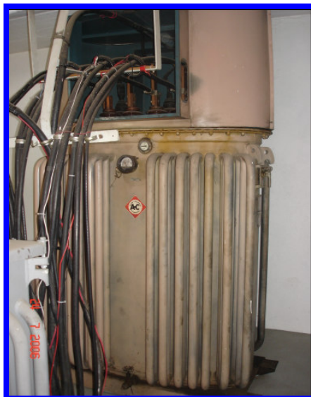
Fotografía 7 y 8. Transformador de 550 kVA ubicado en Instituto de Ingeniería, a la derecha se muestra un transformador de 500 kVA ubicado en la Facultad de Química Edificio "B".
