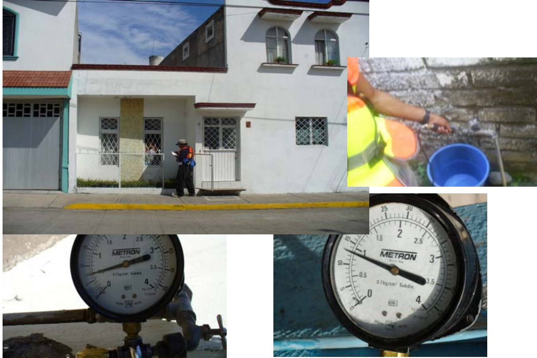
Figura 3.22. Toma de presión en toma domiciliaria doméstica de ½". Con un valor de 0.5 y en otra zona con una presión de 0.9 Kg/cm 2
