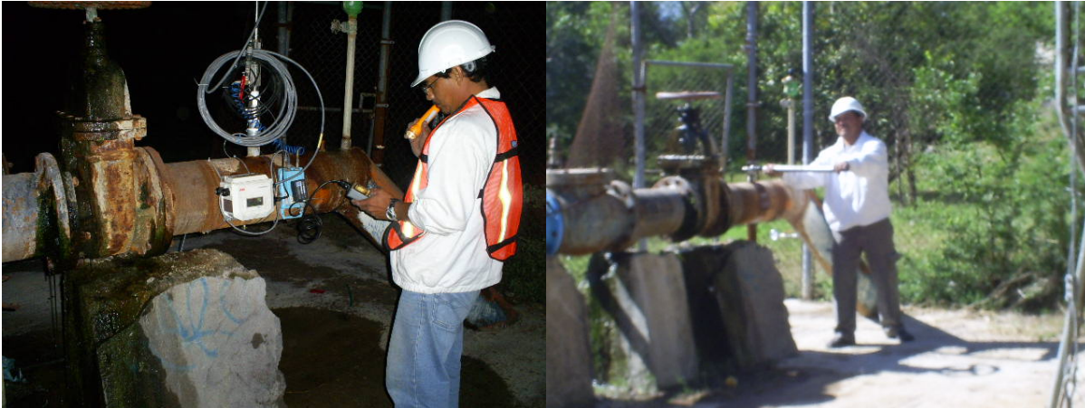
Figura 3.1. Instalación de válvula y medidor electromagnético a la descarga del pozo Santa Fe, de 10" de diámetro.
