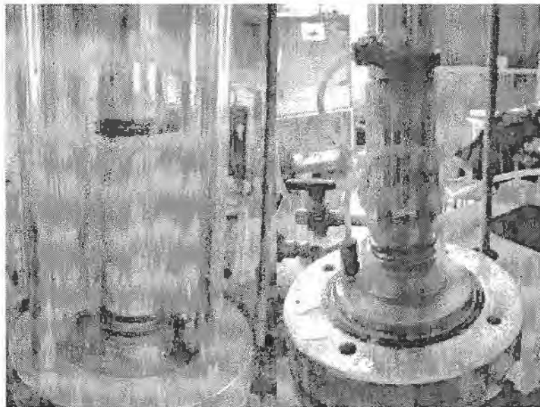
Fotografía 41 Drenado de la cámara.
