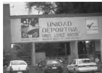
52- Fachada de la Unidad Deportiva
