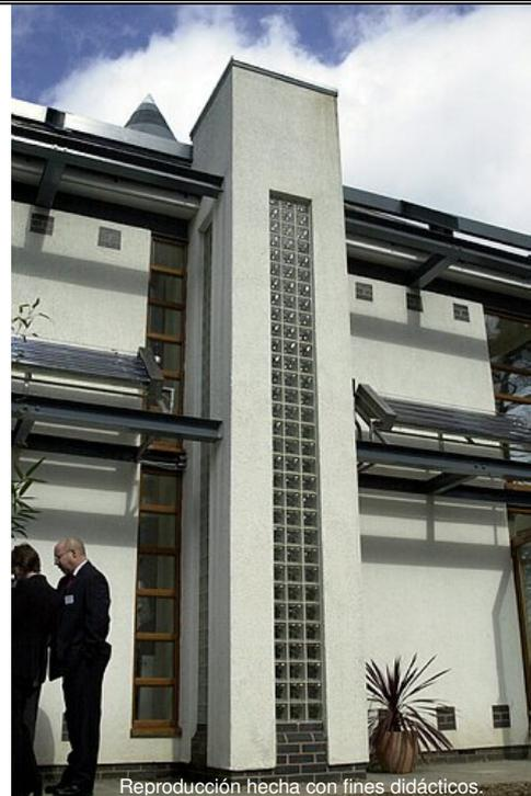
Imagen21. Chimenea solar como aplicación para calefacción.
