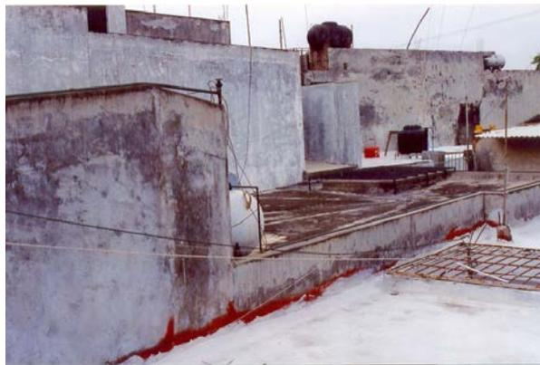
Imagen 10. Muros y techumbres sufren el ataque de hongos debido a la humedad presente en el ambiente.
