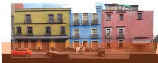
Levantamiento fotográfico parcial de la calle de Soledad
