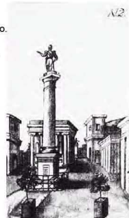
Imagen de Abraham López donde nos muestra el monumento del Gral. Santa Anna ubicado al centro de las construcciones del nuevo Mercado del Volador, que el mismo mandaría construir.
