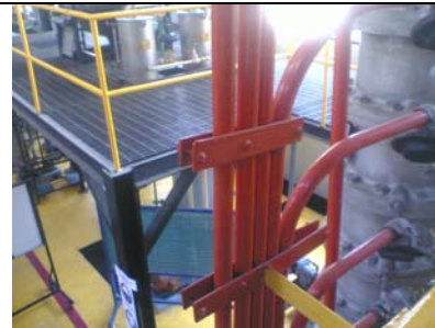
Pieza soporte atornillada con tornillos cabeza de gota ranurada.
