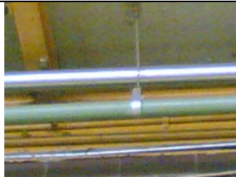
Soporte en estribo con espárrago de ajuste cada 3 m.
