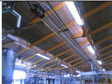
Haz de tres tubos sostenido por columpio con espárrago de ajuste.
