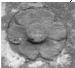
Fotos 34-36. Flores empotradas en el contrafuerte del muro norte
