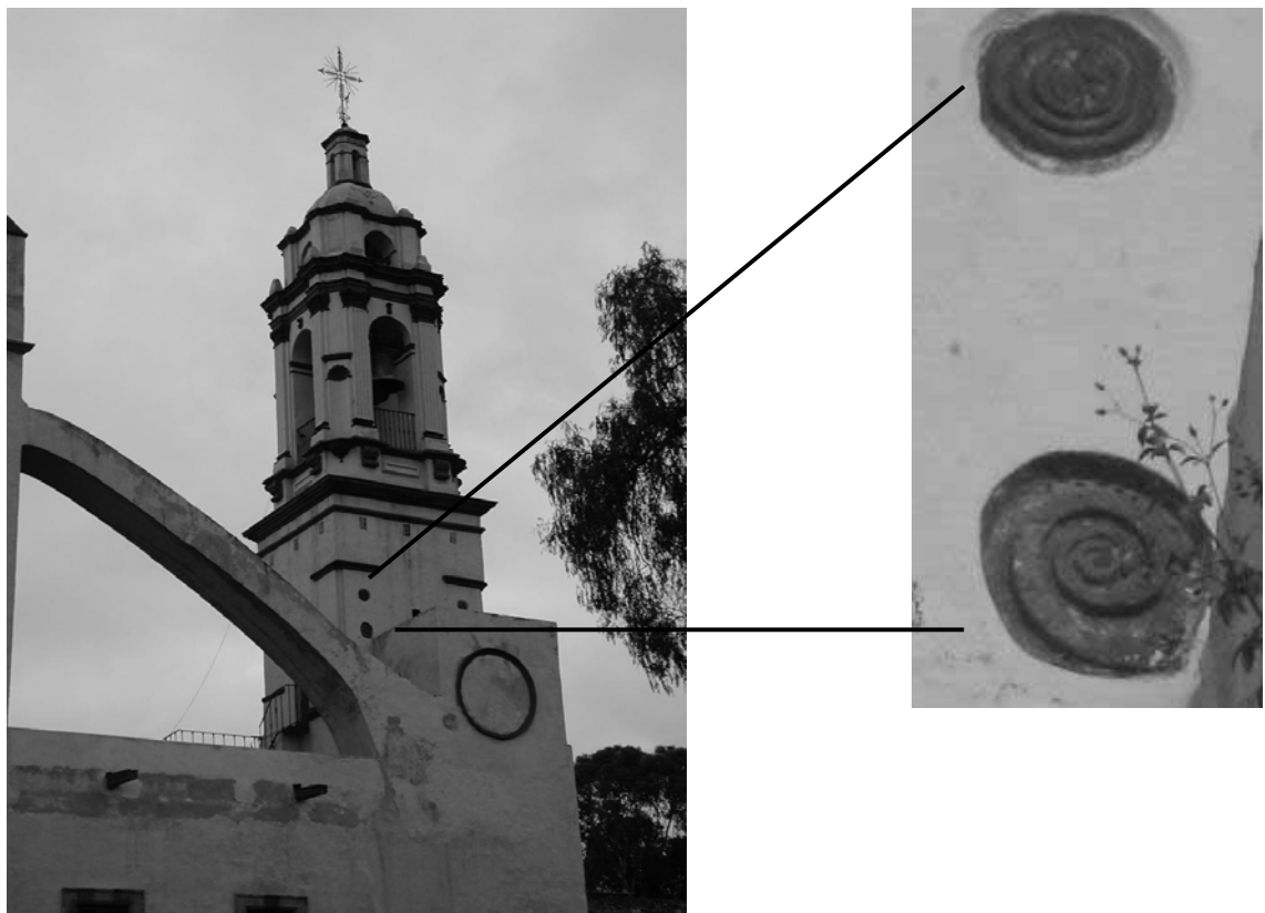
Fotos 6 y 7. Figuras localizadas en muro poniente de la torre
