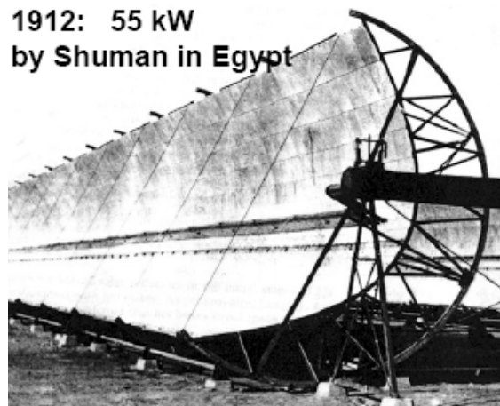
Figura 1.2. Primera planta de generación de energía mediante colectores parabólicos en Maadi, Egipto, 1912
