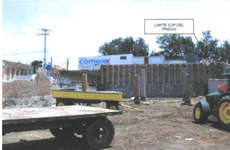
TOMA FOTOGRAFICA 8.- Panorámica del interior del predio, tomada de Poniente a Oriente, en la que se aprecian los muros delimitantes del terreno, al fondo hacia la calle 5 de Mayo y del lado izquierdo de la foto hacia la calle 16 de Septiembre, asimismo se observa la delimitación Sur del terreno y el desmantelamiento de lo que fue una antigua granja de ganado porcino.
