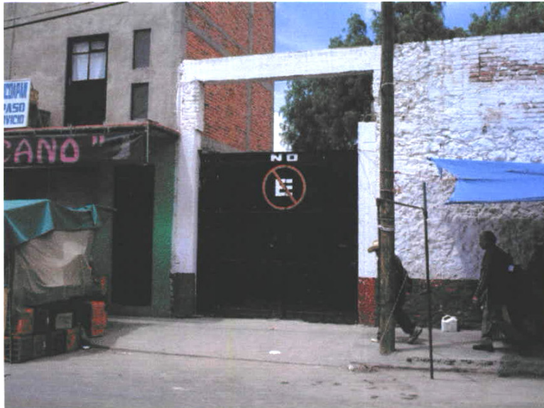
TOMA FOTOGRAFICA 3.- Vista del acceso principal al predio, sobre la calle 5 de Mayo, foto tomada desde el expendio de pinturas que está frente al terreno.
