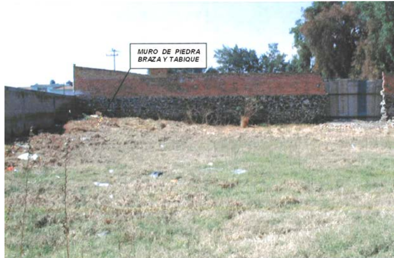
TOMA FOTOGRAFICA 6. -Vista posterior del predio donde apreciamos al fondo un muro de piedra braza y tabique que divide transversalmente el terreno, también se observa una ligera pendiente del terreno de Noreste a Suroeste, que está cubierto por pasto semiseco, la foto esta tomada de Poniente a Oriente.
