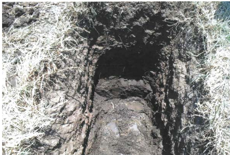
Vista de las paredes de la excavación para el PCA-A, en la que se aprecia una capa superficial de suelo vegetal, con espesor de hasta 0.95 m, al fondo se observa el nivel de aguas freáticas.
