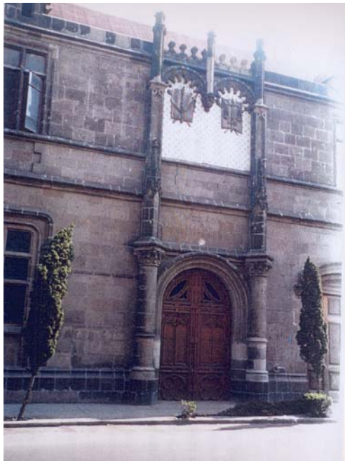
Lam. 8 Acceso a Juzgados, calle Revillagigedo.
