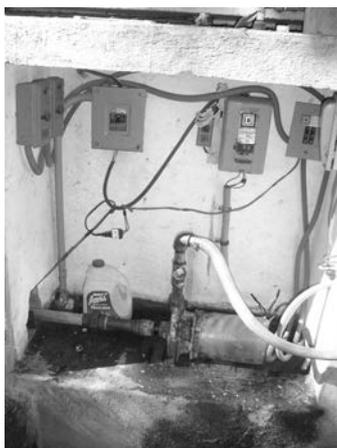
Fig. 1.4. Controles eléctricos del equipo de bombeo
