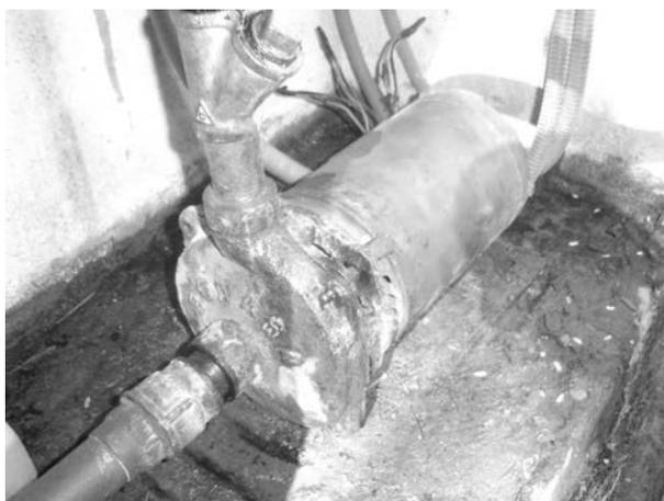
Fig. 1.2. Bomba de 2 HP para bombeo de agua al tanque de almacenamiento
