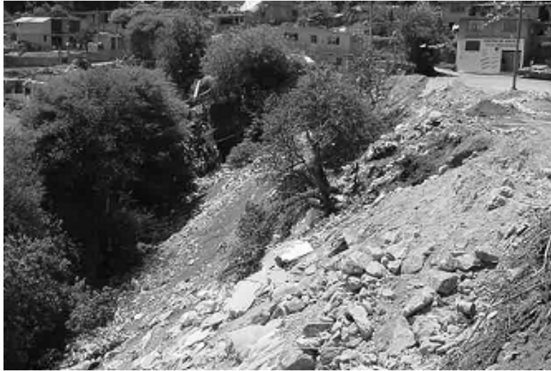
Fig. 13.2. Relleno de cuencas con cascajo y basura.
