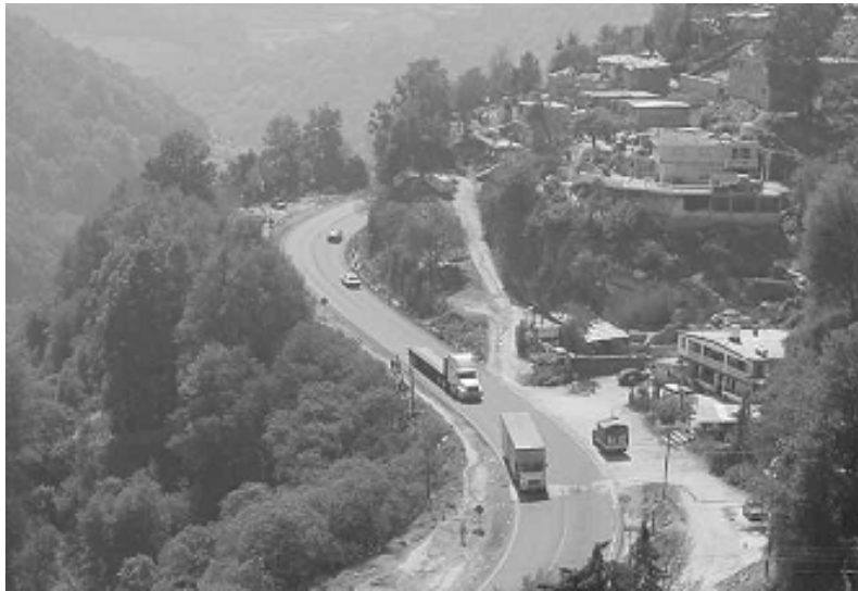
Fig. 10.1. Carretera federal México-Toluca.
