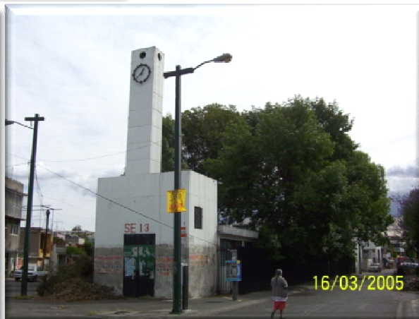
Puentes y Reloj Antes y Después
